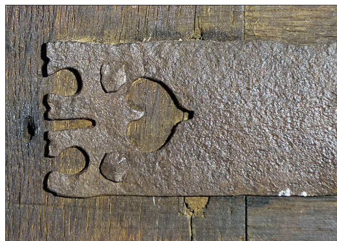
Fig. E.6. Extrémité de la charnière de la croisée du petit logis
