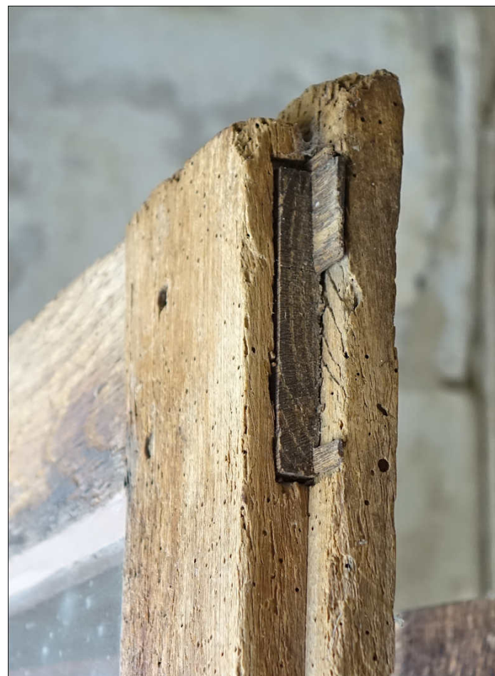
Fig. E.5. Assemblage traversé du vantail vitré de la croisée du petit logis
