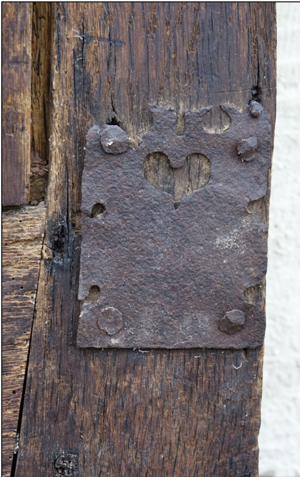
Fig. 8.2. Platine de targette
