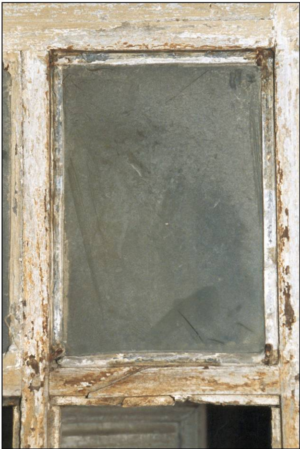
Fig. 4.3. "carreau de verre mis en plomb"
