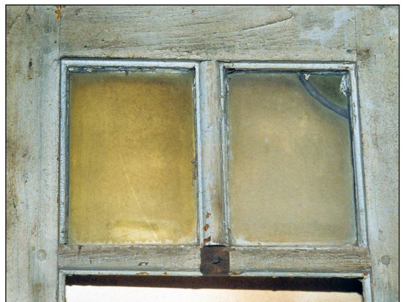
Fig. 4.6. Carreaux de verre et petits-bois (intérieur)
