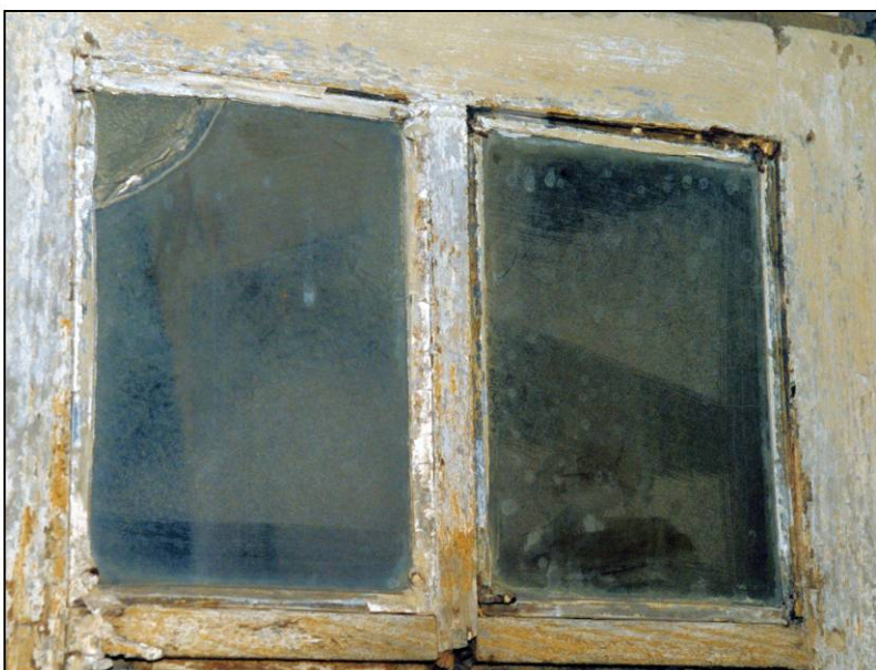
Fig. 4.5. Carreaux de verre et petits-bois (extérieur)
