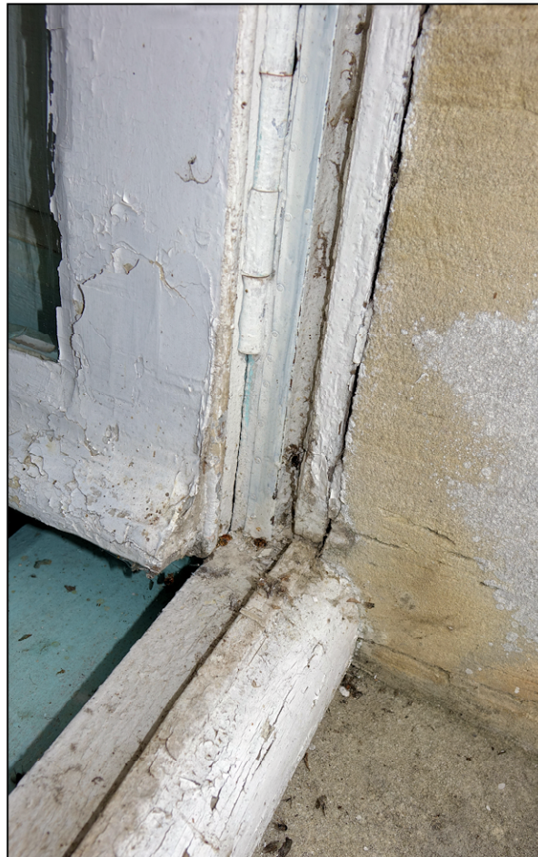
Fig. 12.5. Pièce d'appui et jet d'eau
