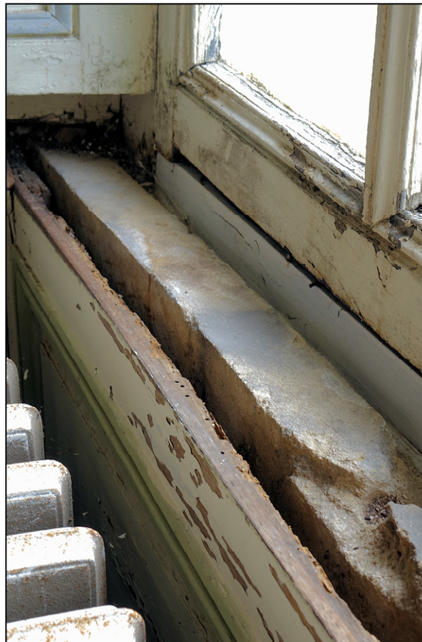
Fig. 6.4. Relevé de l'appui en pierre
