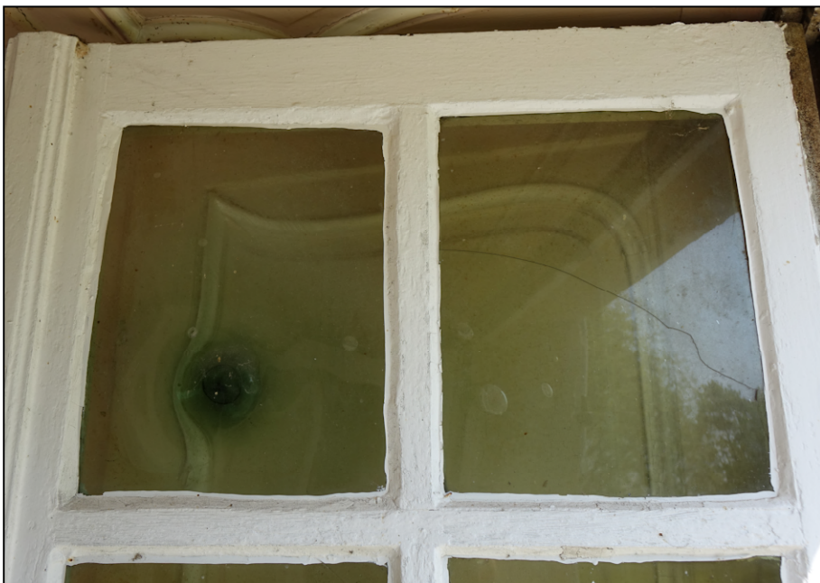
Fig. 2.3. Vitrage (boudine à gauche)
