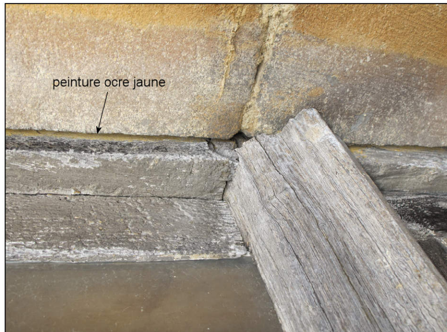
Fig. 12.2. Meneau et traverse haute (K)
