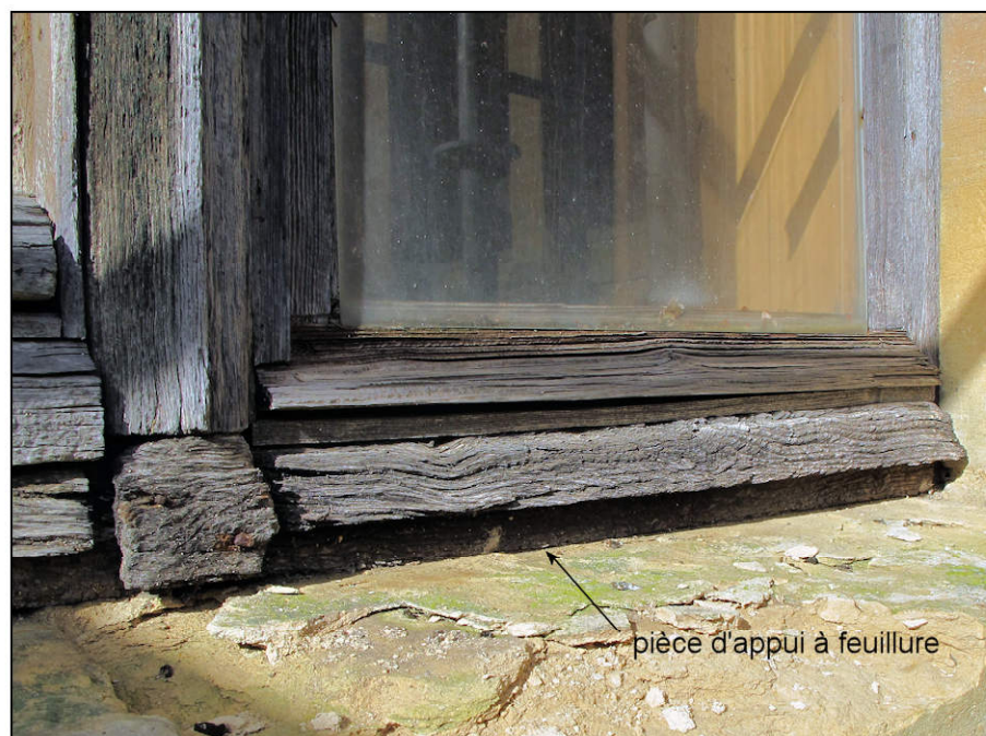
Fig. 12.3. Pièce d'appui (K)
