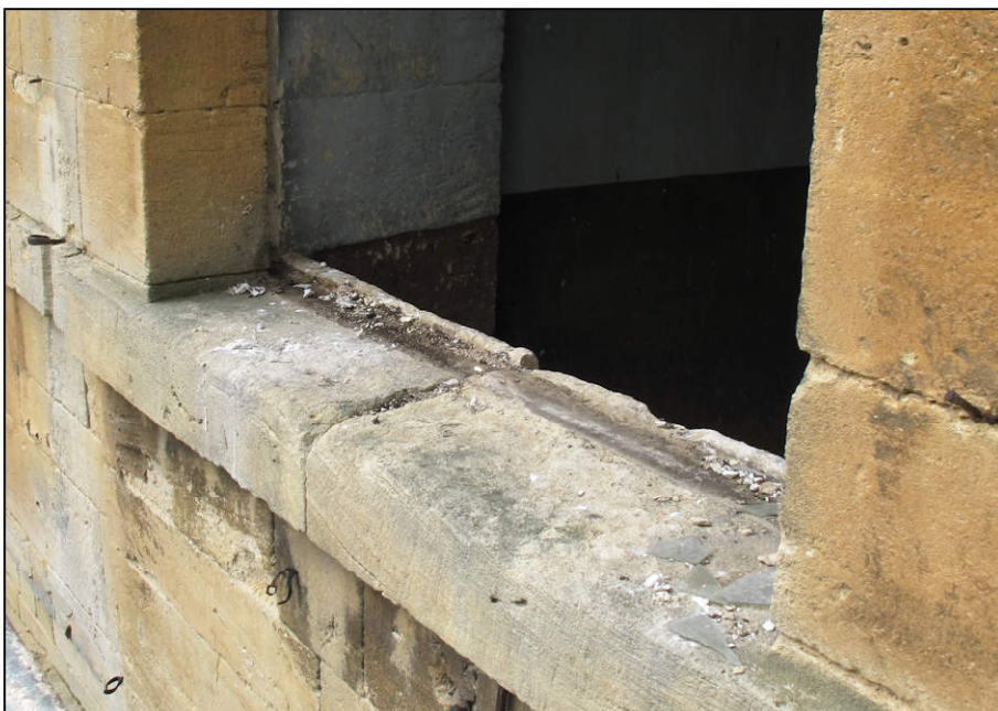
Fig. 11.5. Appui avec relevé (aile ouest / extrémité nord)
