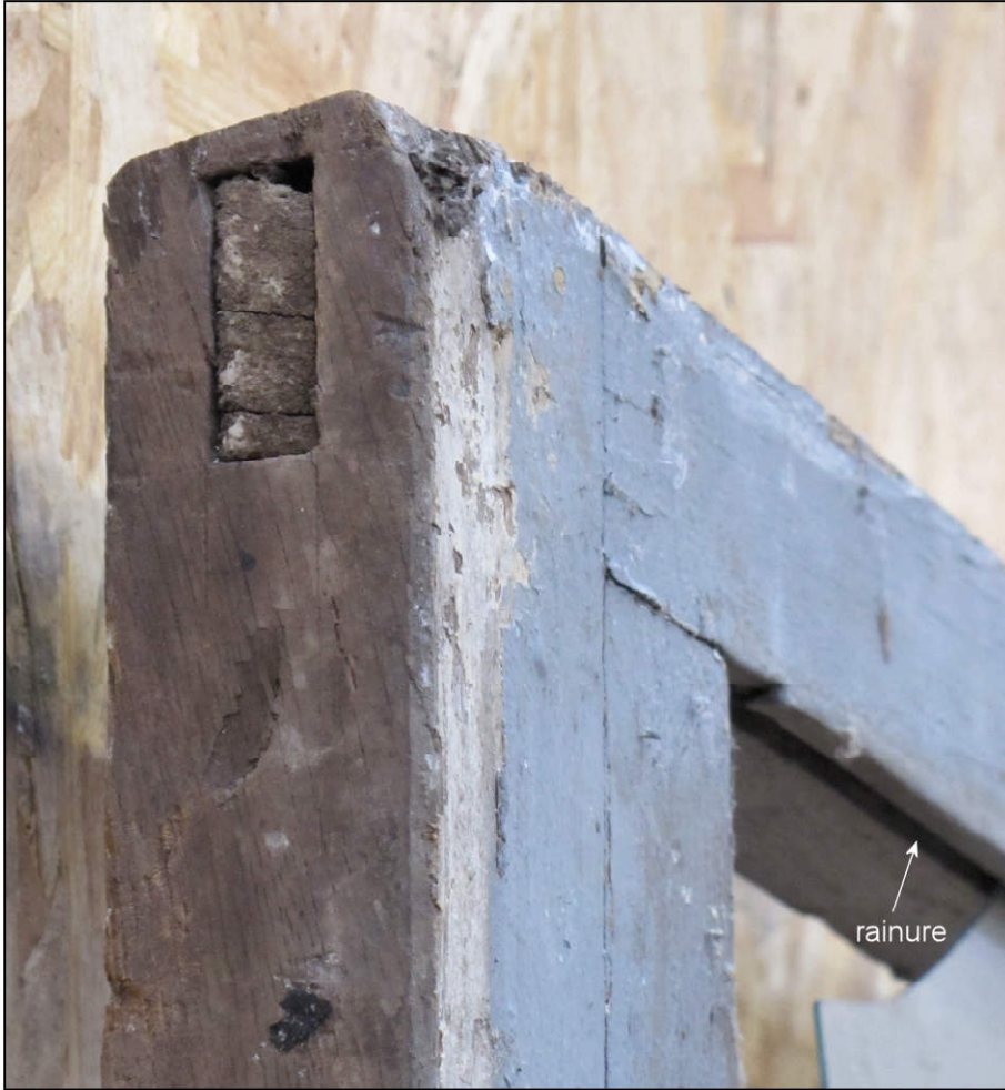
Fig. 11.1. Traverse haute / assemblage
