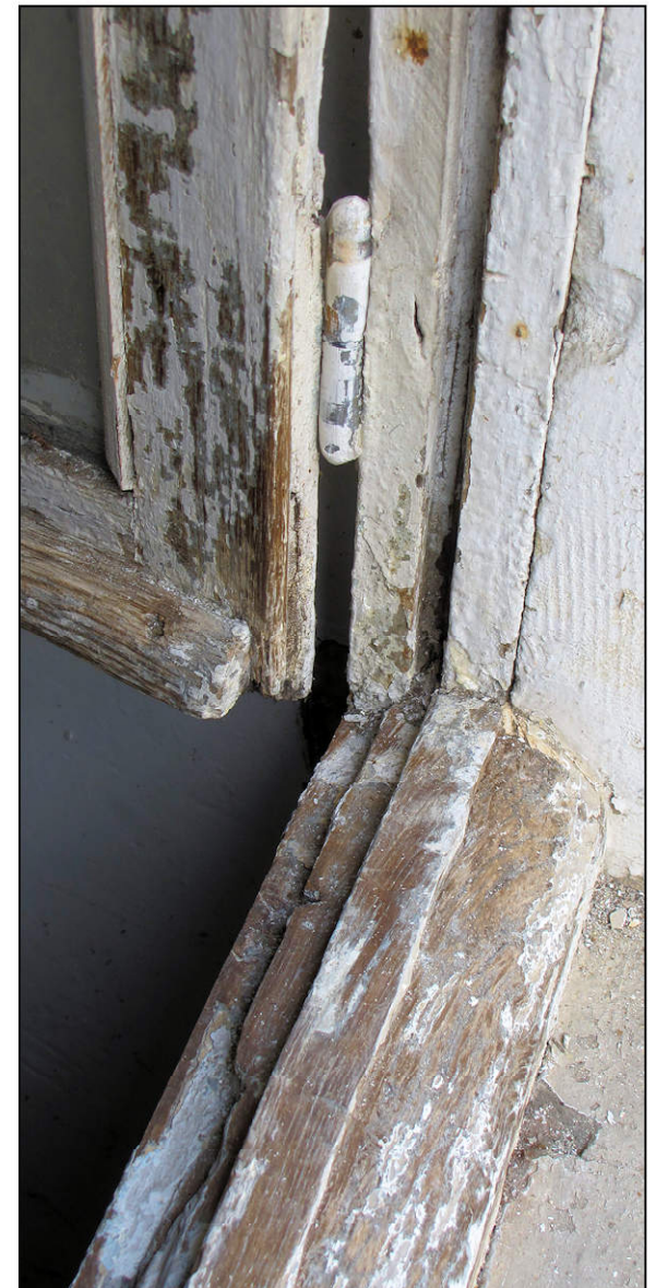
Fig. 8.4. pièce d'appui et jet d'eau
