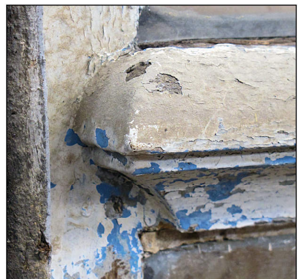
Fig. 7.8. Vantail vitré / traverse (châssis D)
