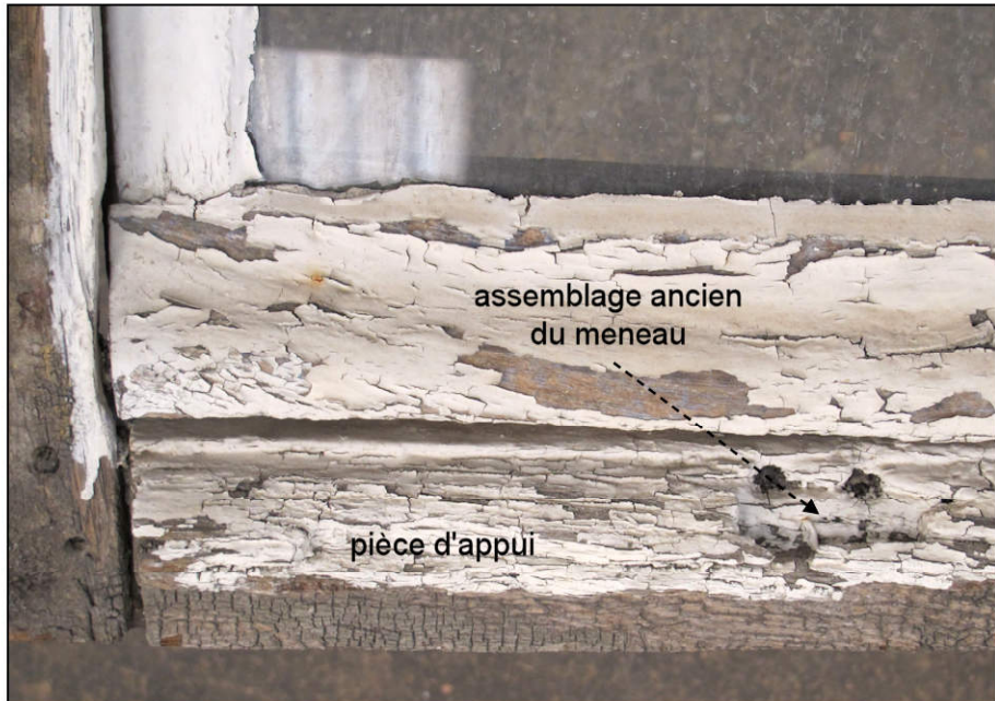
Fig. 7.3. Pièce d'appui réutilisée et jet d'eau refait (châssis E)
