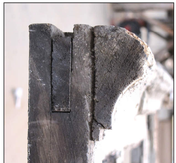
Fig. 7.7. Croisillon remanié (châssis D)
