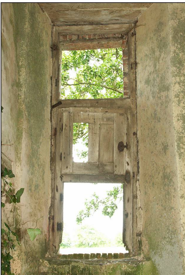
Fig. 4.5. Demi-croisée (façade nord-est)
