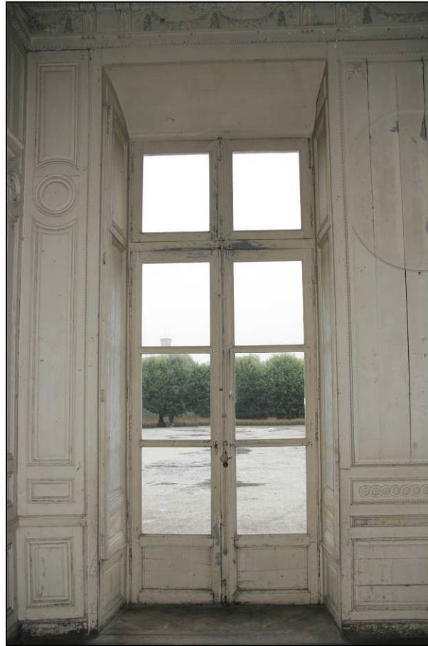
Fig. 7.2. Façade nord (niveau 1 / baie 7)
