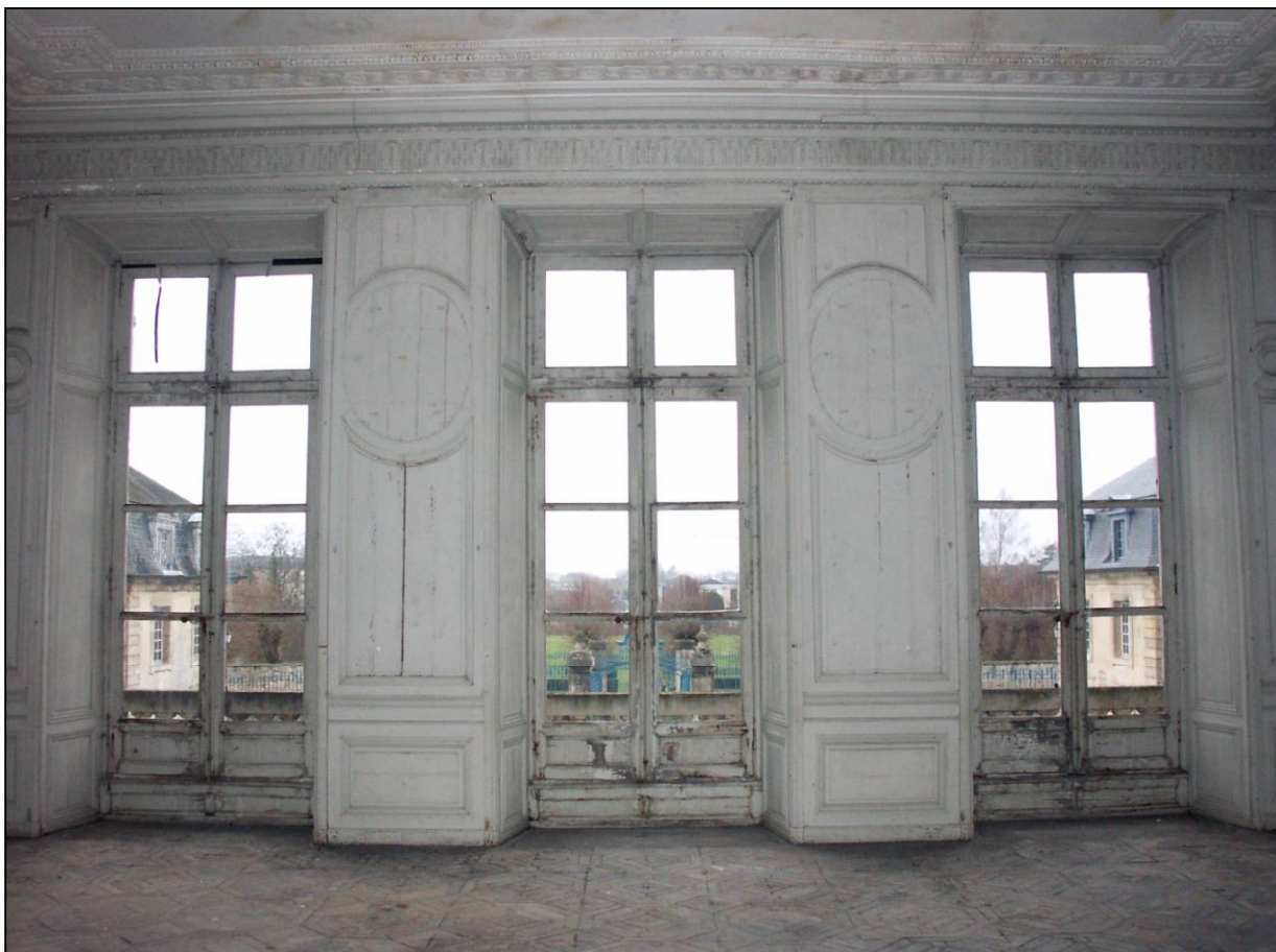
Fig. 2.5. Façade sud (niveau 2 / corps central / fenêtres 4, 5 et 6)
