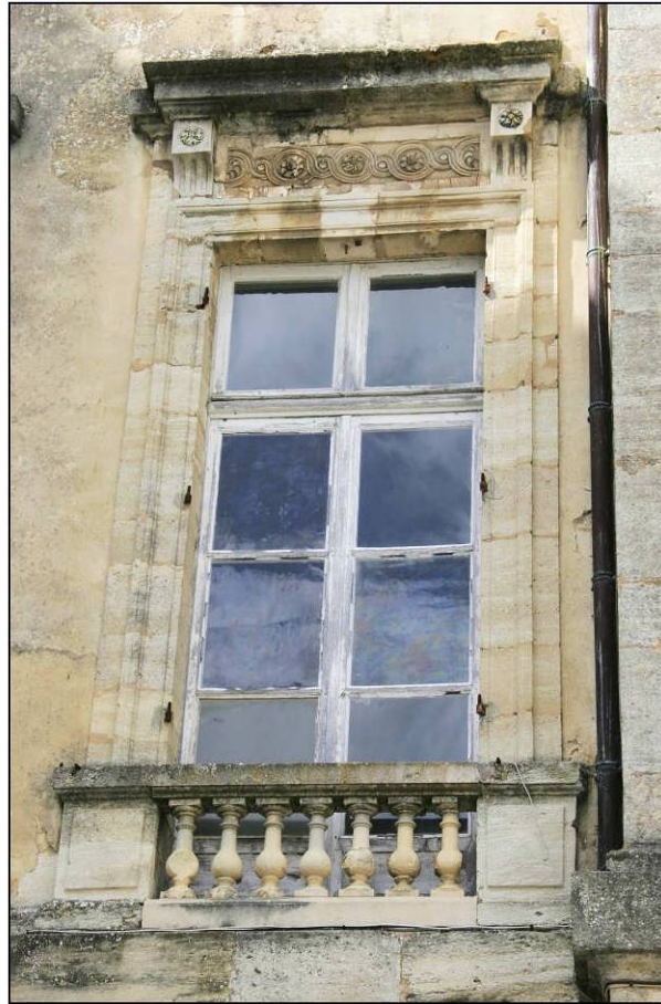
Fig. 2.2. Façade sud (niveau 2 / fenêtre 3)
