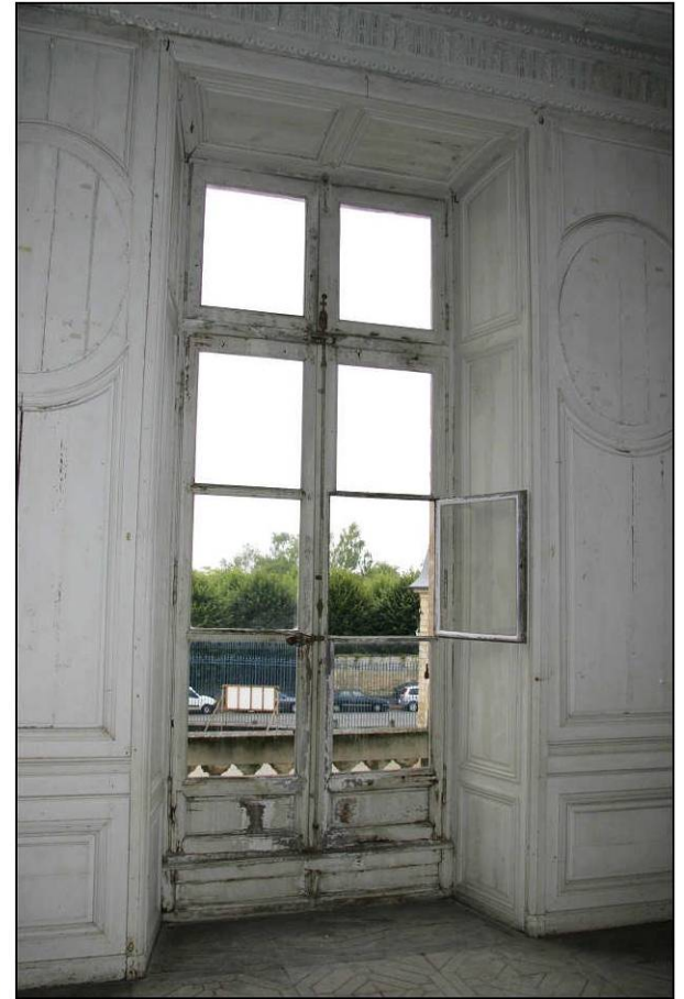
Fig. 2.3. Façade sud (niveau 2 / fenêtre 5)
