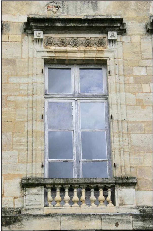
Fig. 2.1. Façade sud (niveau 2 / fenêtre 5)
