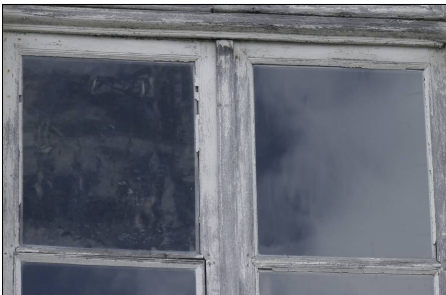
Fig. 2.6. Façade sud (niveau 2 / fenêtre 5)
