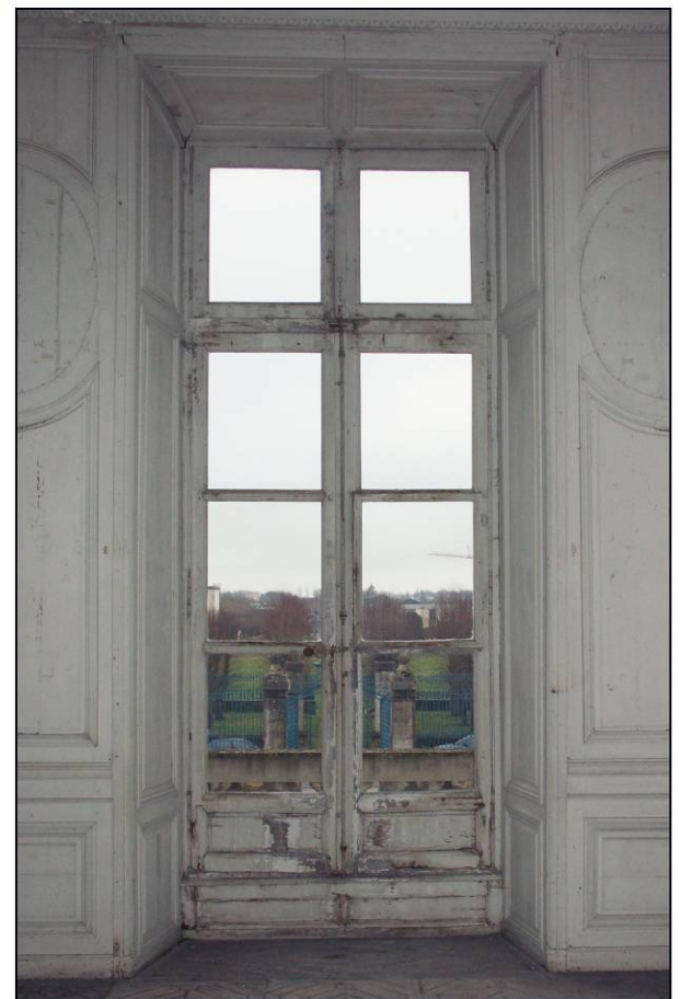
Fig. 2.5. Façade sud (niveau 2 / fenêtre 5)
