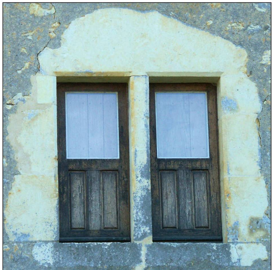
Fig. 1.4. Fenêtre et châssis restitué
