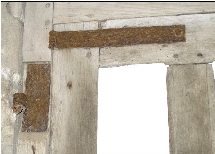
Fig. 2.3. Paumelle et penture
