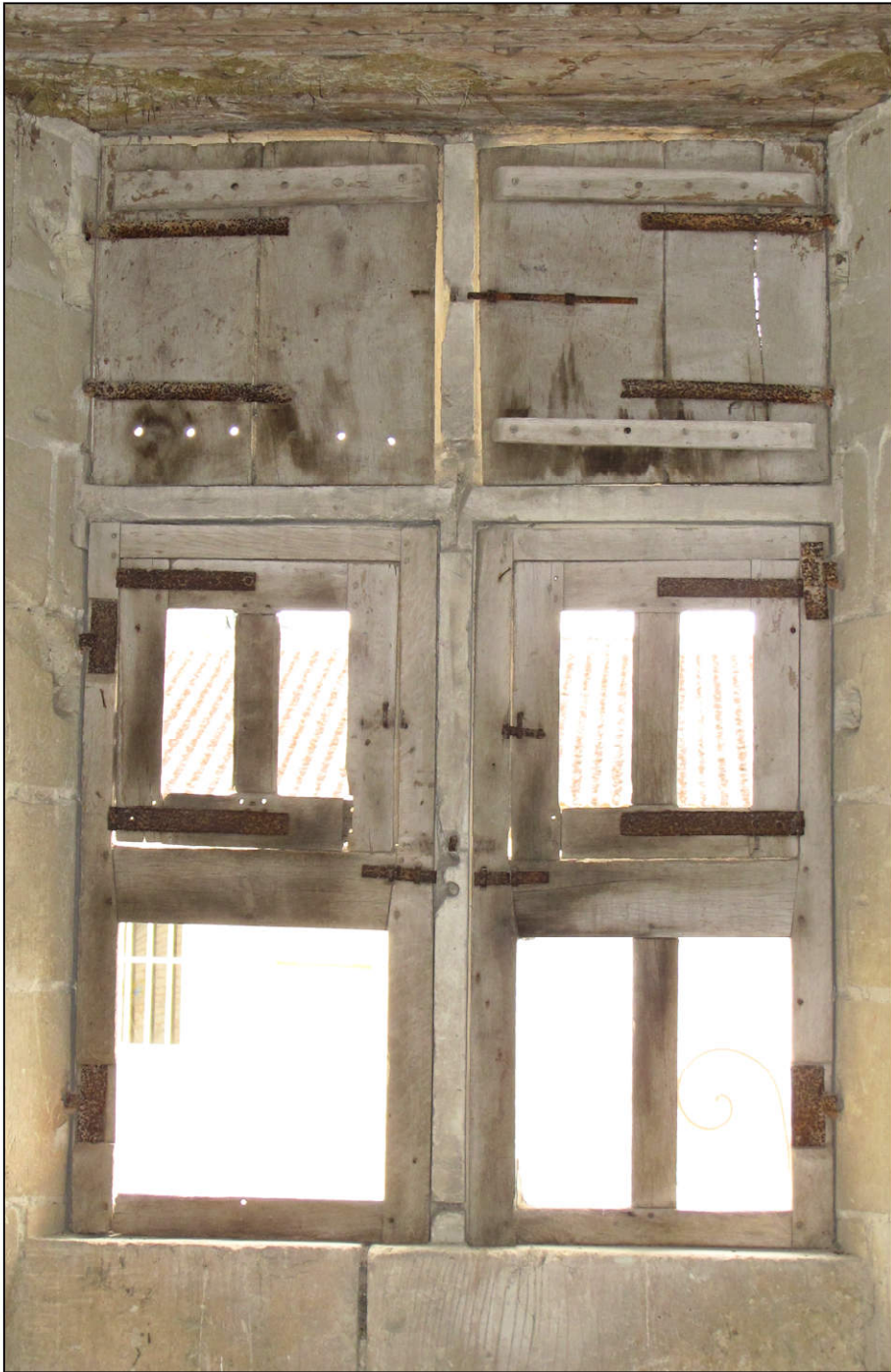
Fig. 1.1. Croisée / élévation intérieure
