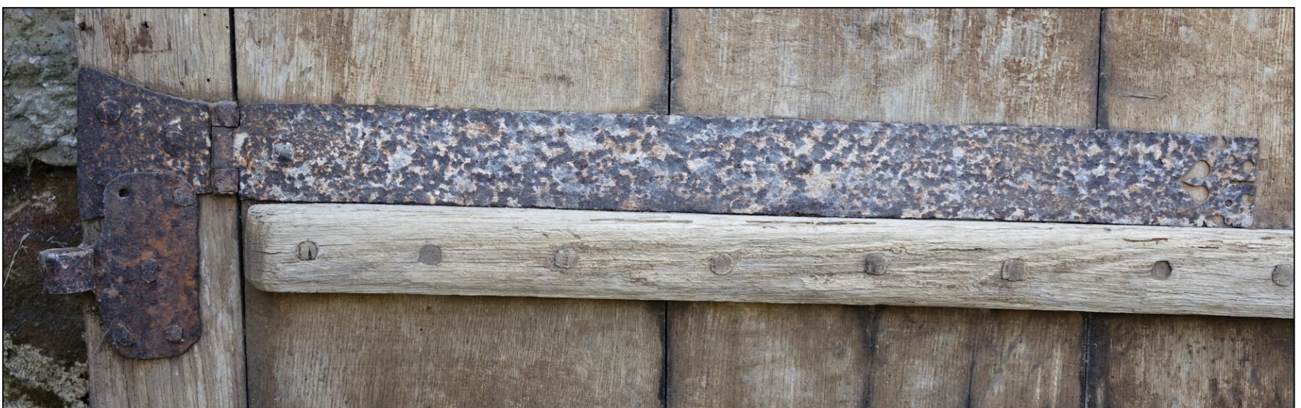
Fig. 3.5. Penture à charnière inférieure
