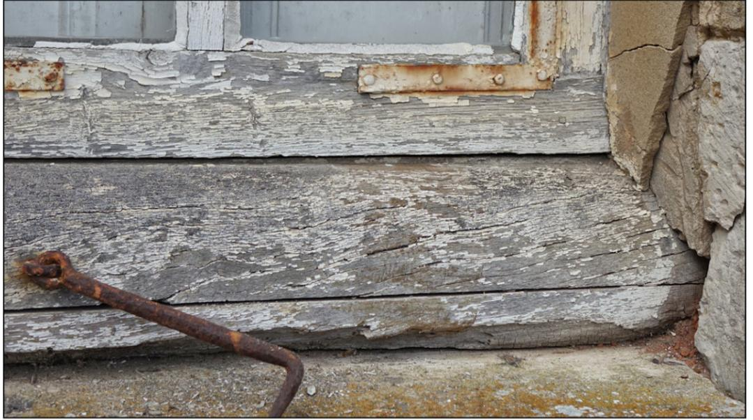
Fig. 6.2. Pièce d'appui et jet d'eau
