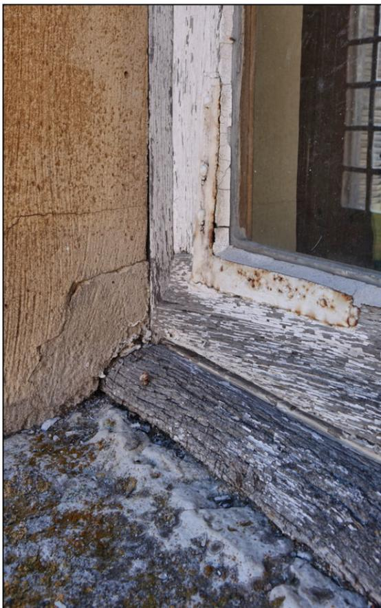
Fig. 3.3. Pièce d'appui et jet d'eau
