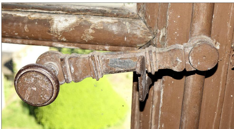
Fig. E.2. Aile et broche d'une fiche à bouton (type 1)
