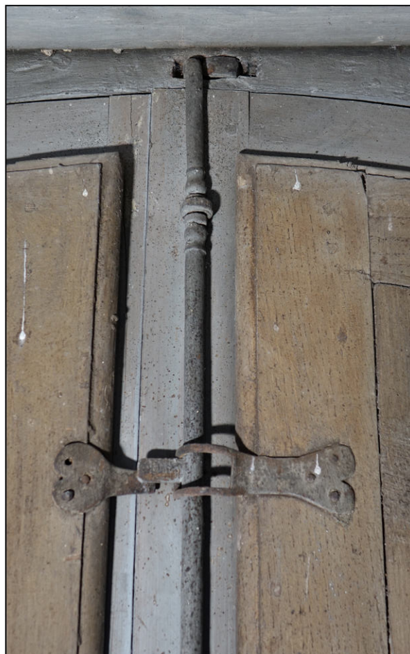
Fig. 6.4. Contre-panneton, panneton et agrafe
