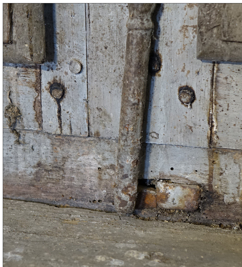
Fig. E.7. Moulure flottée du jet d'eau, avec encastrement en biais (type 3)
