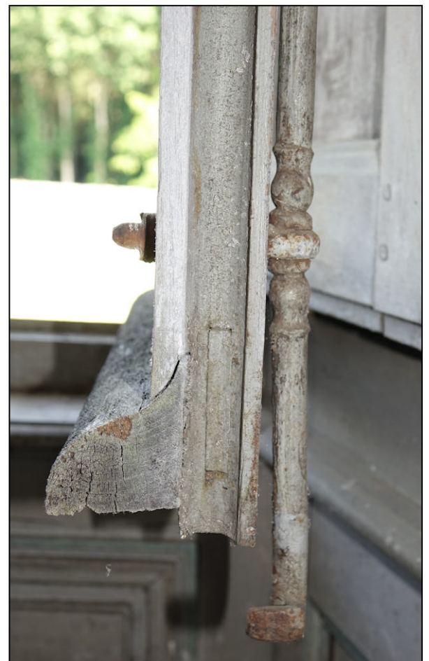
Fig. 6.5. Embase et crochet d'espagnolette
