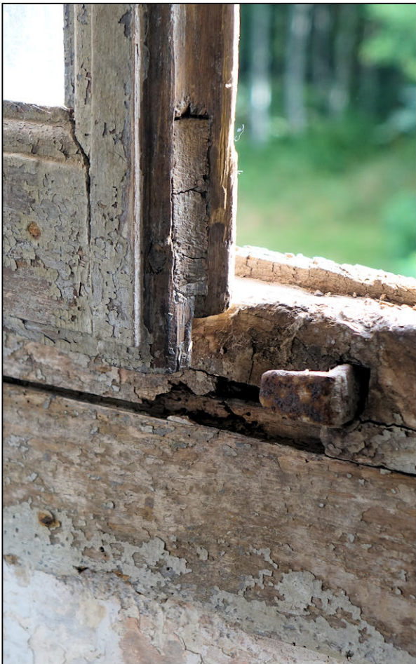
Fig. 3.5. Pièce d'appui
