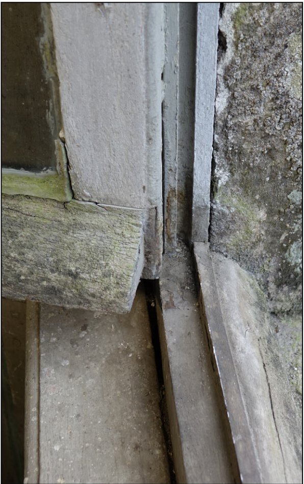
Fig. 5.5. Jet d'eau et pièce d'appui
