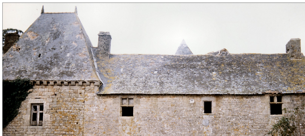
Fig. E.1. Façade sud sur cour (étage)
