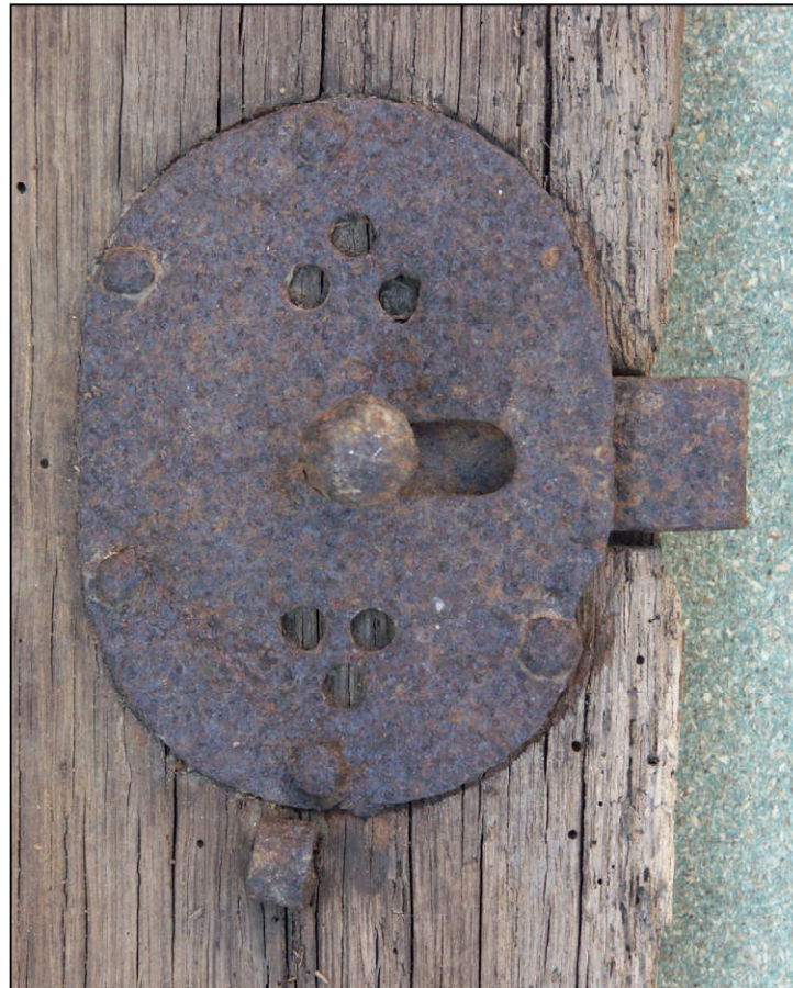
Fig. 3.4. Targette encoisonnée (volet inférieur gauche)
