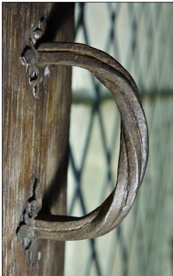
Fig. 11.5. Poignée (croisée 3, vantail sup.)
