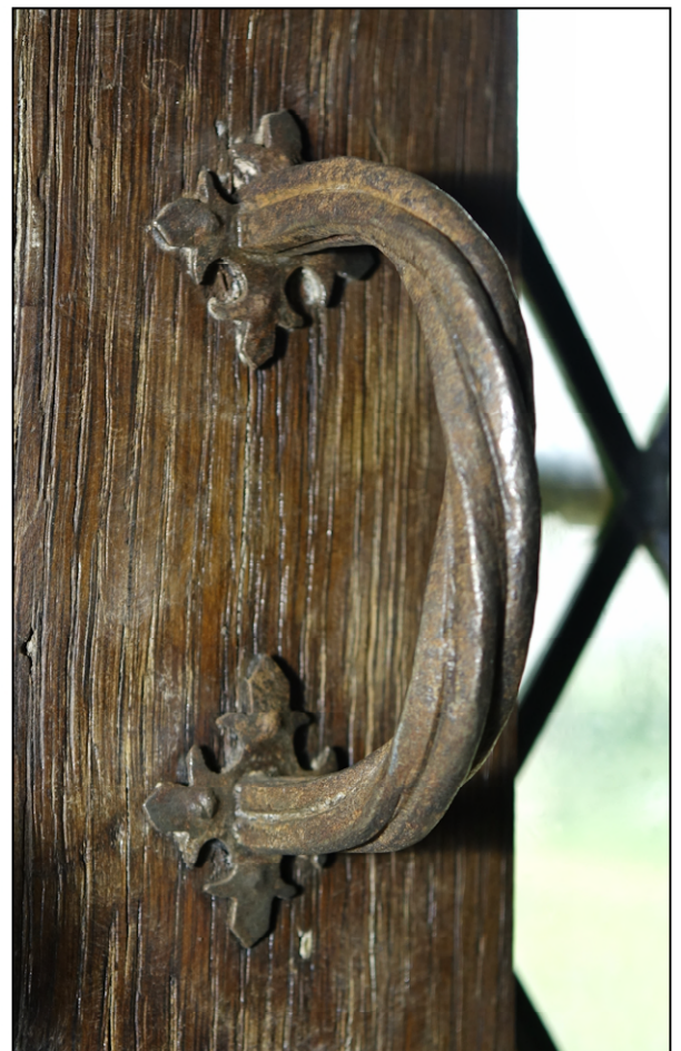
Fig. 11.6. Poignée (croisée 3, vantail sup.)
