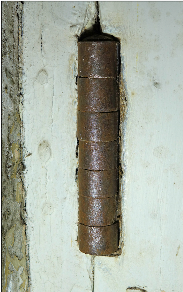
Fig. 11.1. Fiche (croisée 4, vantail vitré inf.)
