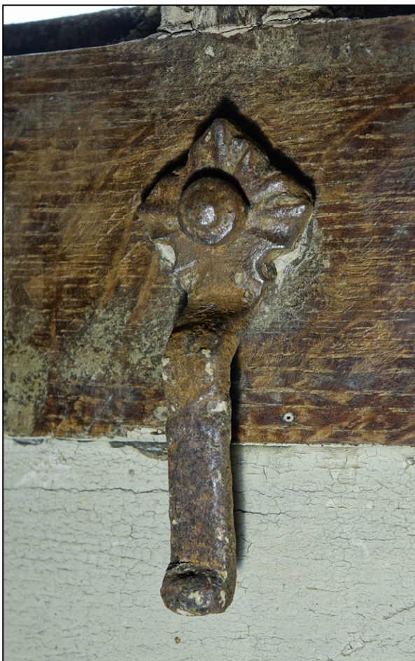
Fig. 11.4. Tourniquet (croisée 2, vantail sup.)
