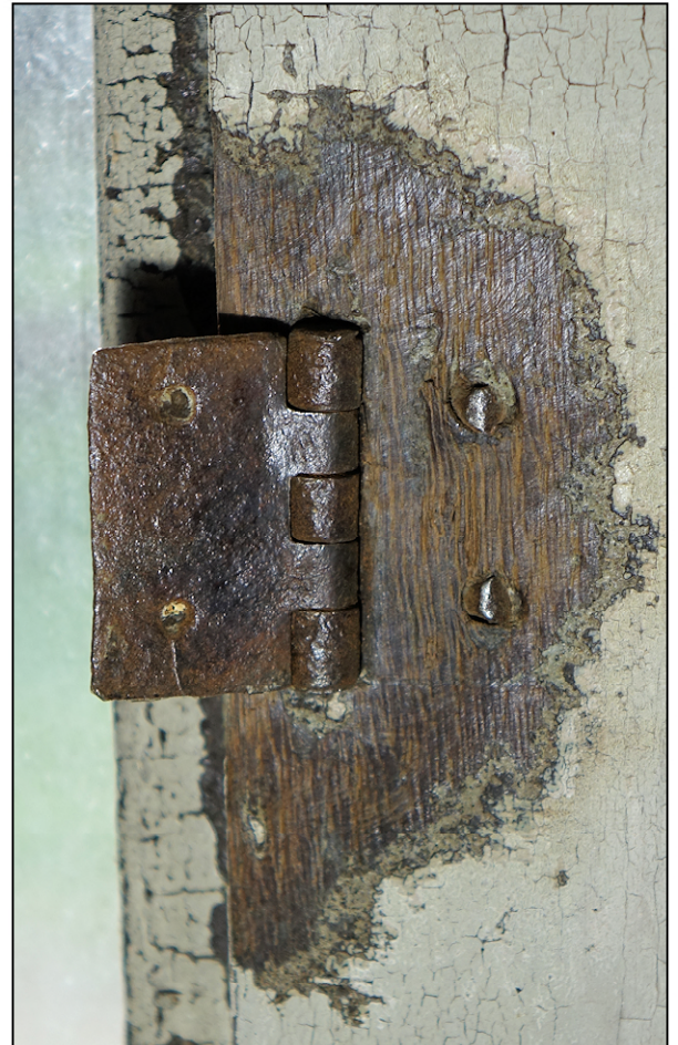
Fig. 11.3. Fiche (croisée 2, vantail vitré inf.)
