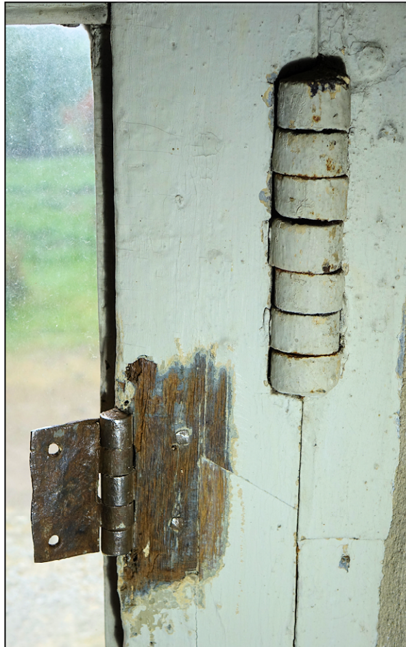
Fig. 11.2. Fiches (croisée 2, vantail vitré inf.)
