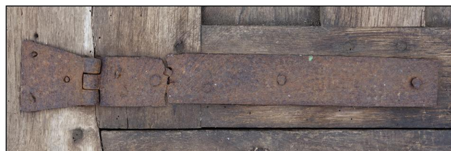
Fig. 1.4. Charnière (vantail inférieur)
