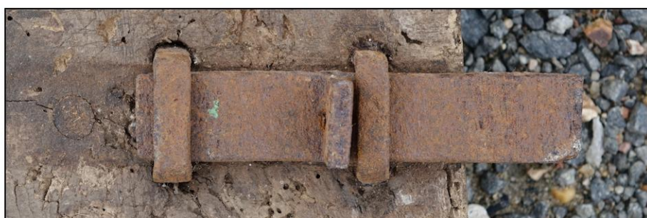
Fig. 1.3. Targette (vantail inférieur)
