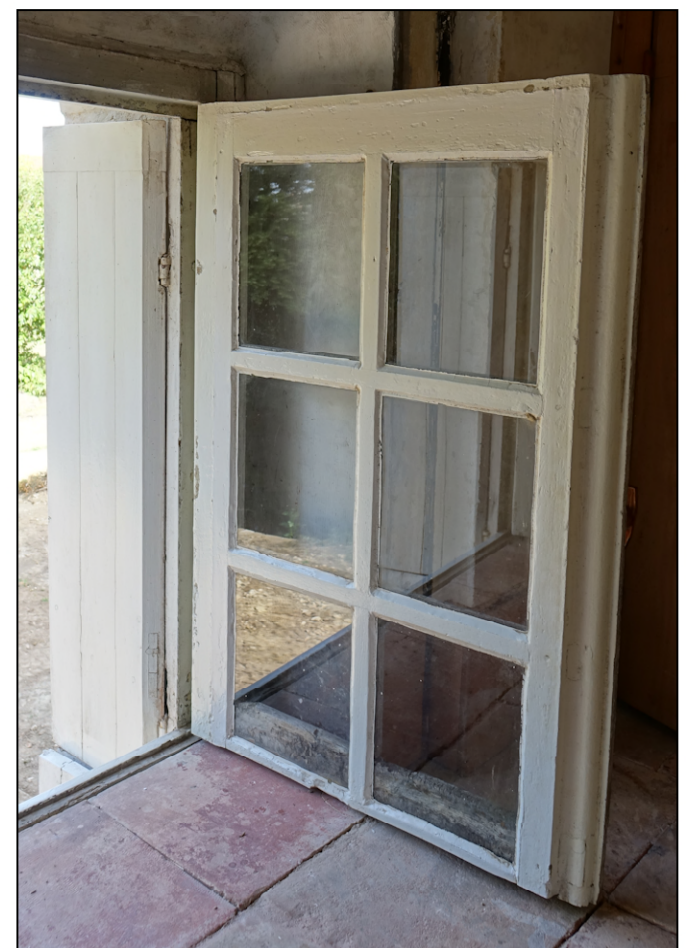
Fig. 7.6. Vantail vitré supérieur droit
