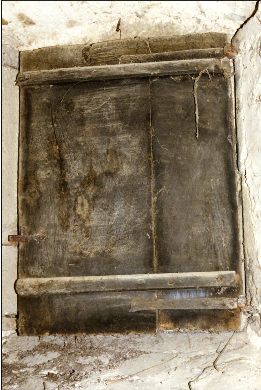
Fig. 4.1. Volet (élévation intérieure)
