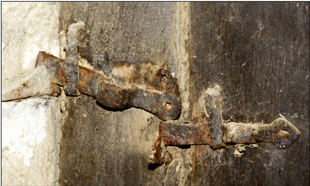
Fig. 3.7. Loquets (vantail et volet supérieurs)
