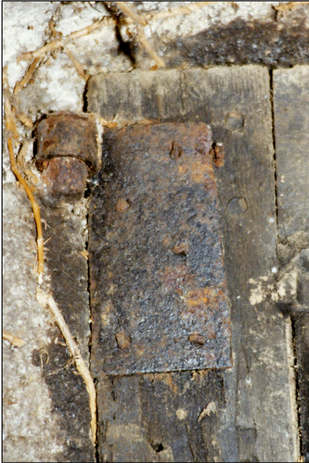
Fig. 2.2. Gond et platine (vantail vitré sup.)
