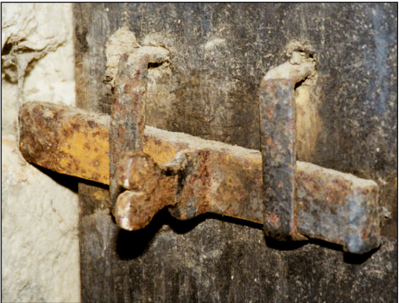
Fig. 3.8. Targette (volet inférieur)
