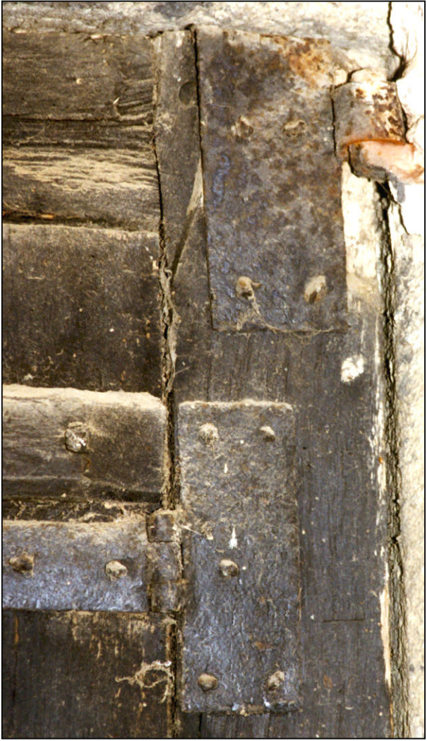
Fig. 3.3. Gond et penture (détail)
