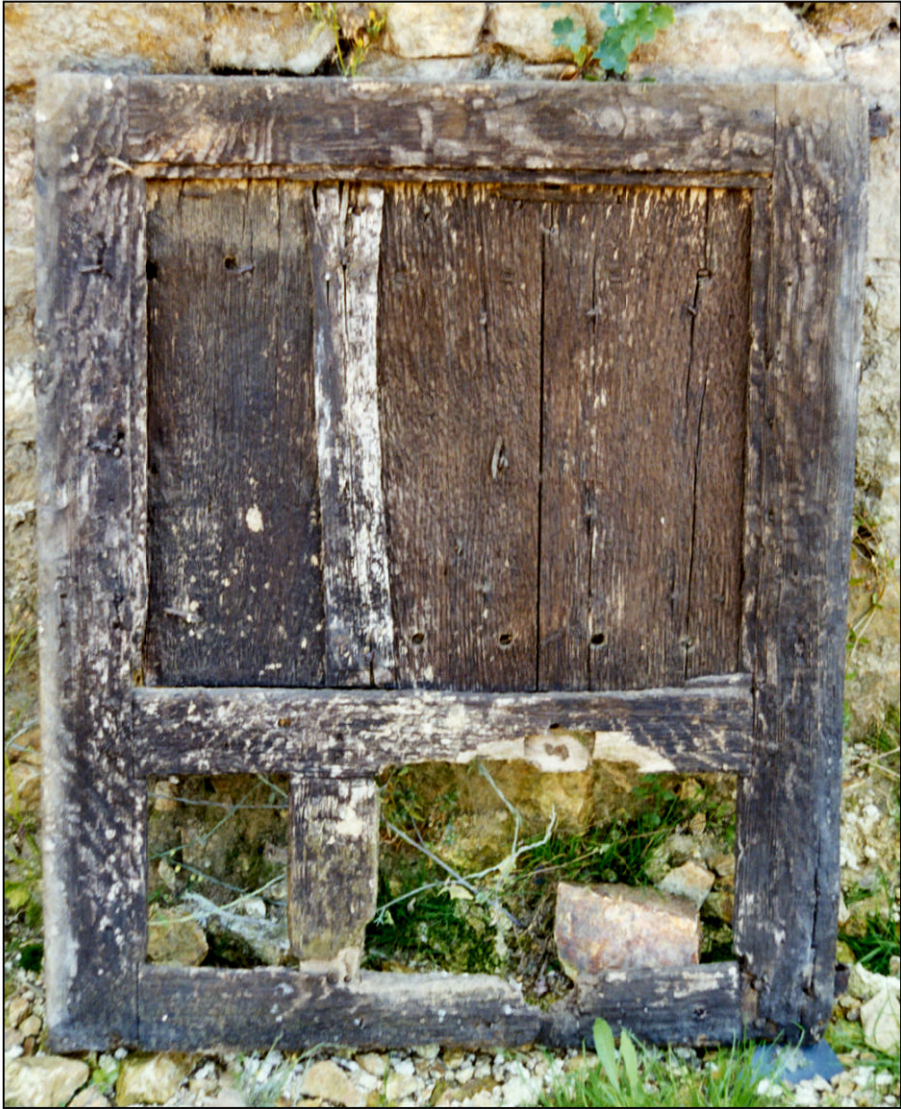
Fig. 1.2. Vantail vitré et volet inférieurs (élévation extérieure)
