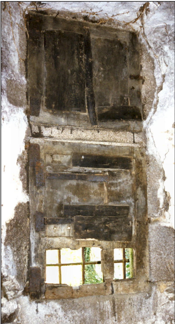
Fig. 1.5. Demi-croisée (élévation intérieure)
