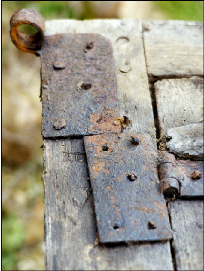
Fig. 2.3. Pentures (vantail vitré et volet inférieurs)
