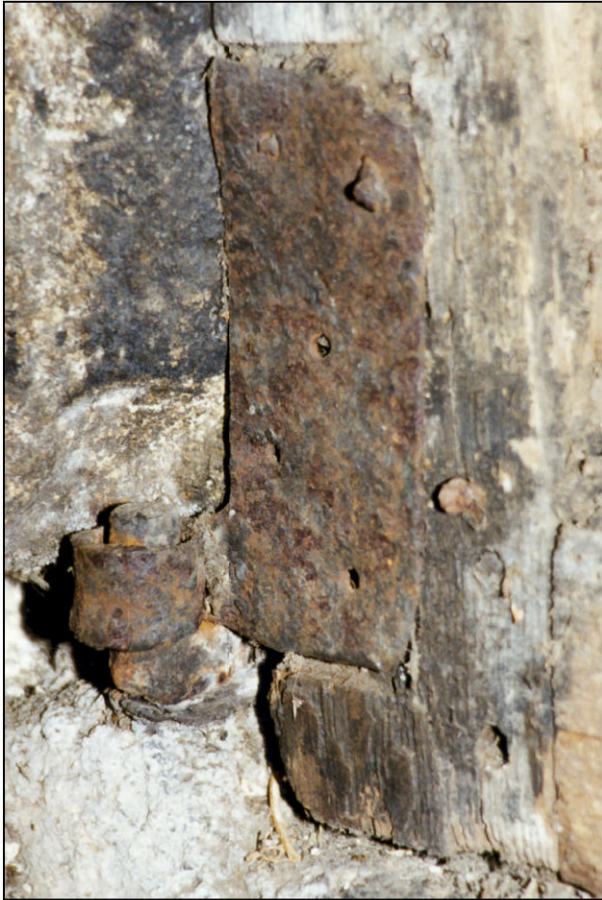
Fig. 2.4. Gond et platine (vantail vitré inf.)
