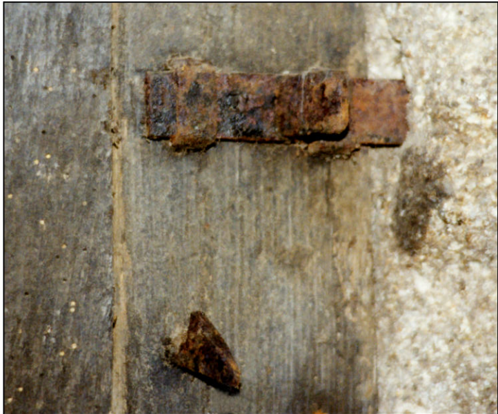
Fig. 2.7. Targette et mentonnet
