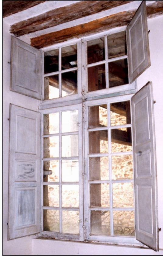
Fig. 1.2. Croisée (élévation intérieure)
