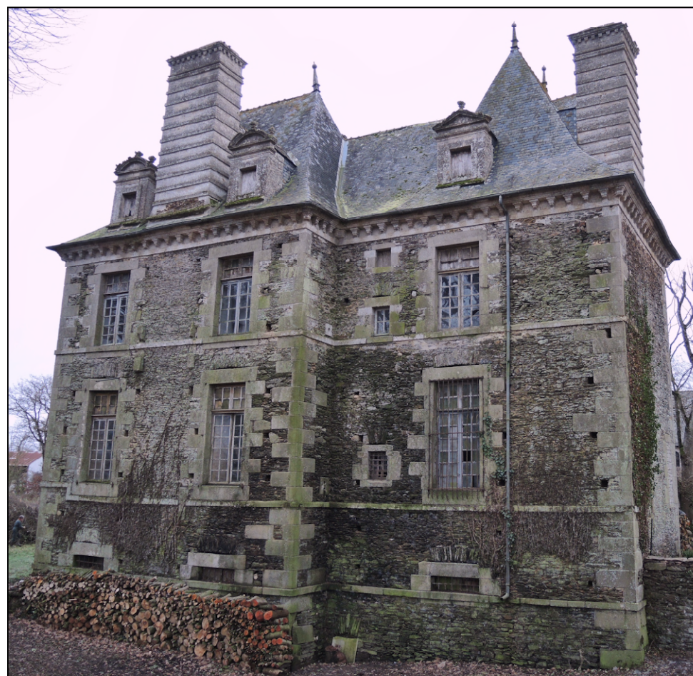
Fig. 1.3. Façade nord (photo Bernard Leprêtre)
