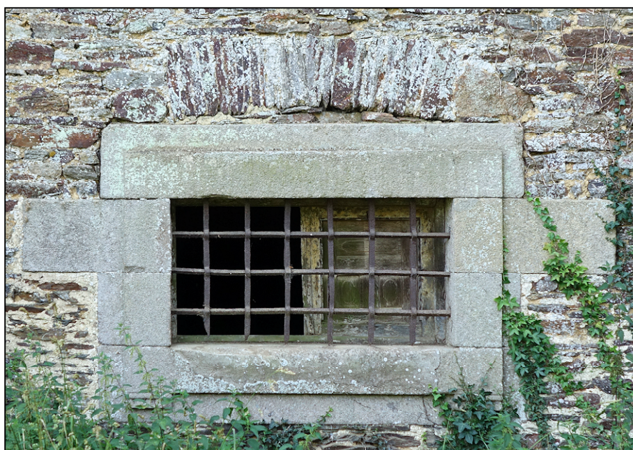
Fig. 1.4. Fenêtre du niveau 1 (façade est / 4e travée)
