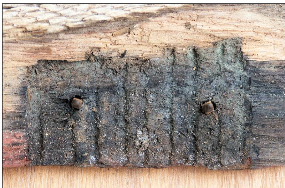
Fig. 3.5. Fiche (mortaise de l'aile)
