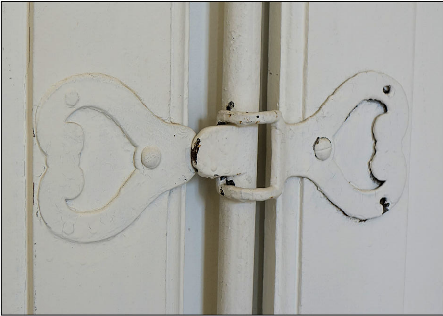
Fig. 5.6. Contre-panneton et agrafe
