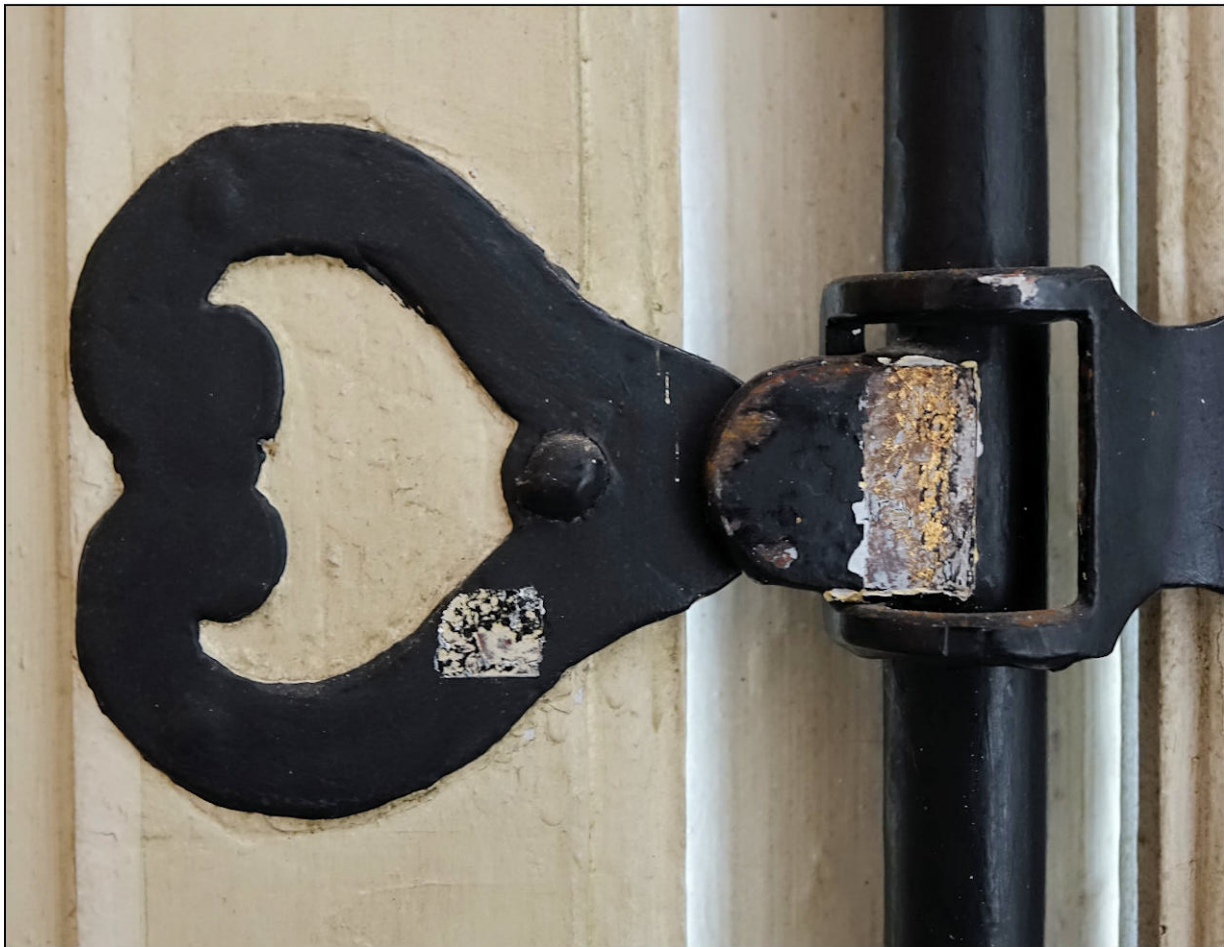
Fig. 6.4. Contre-panneton et panneton*
