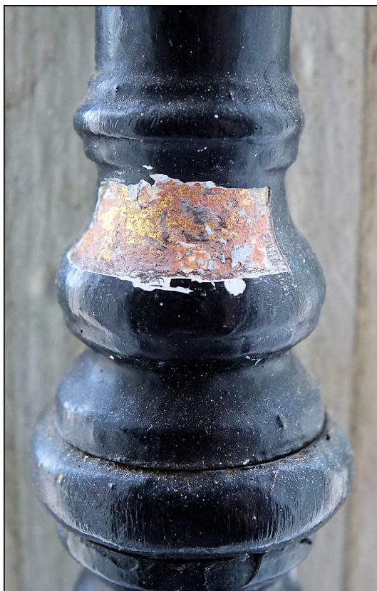
Fig. E.12. (à gauche). Traitement doré du support de poignée d'espagnolette (salle du billard)
