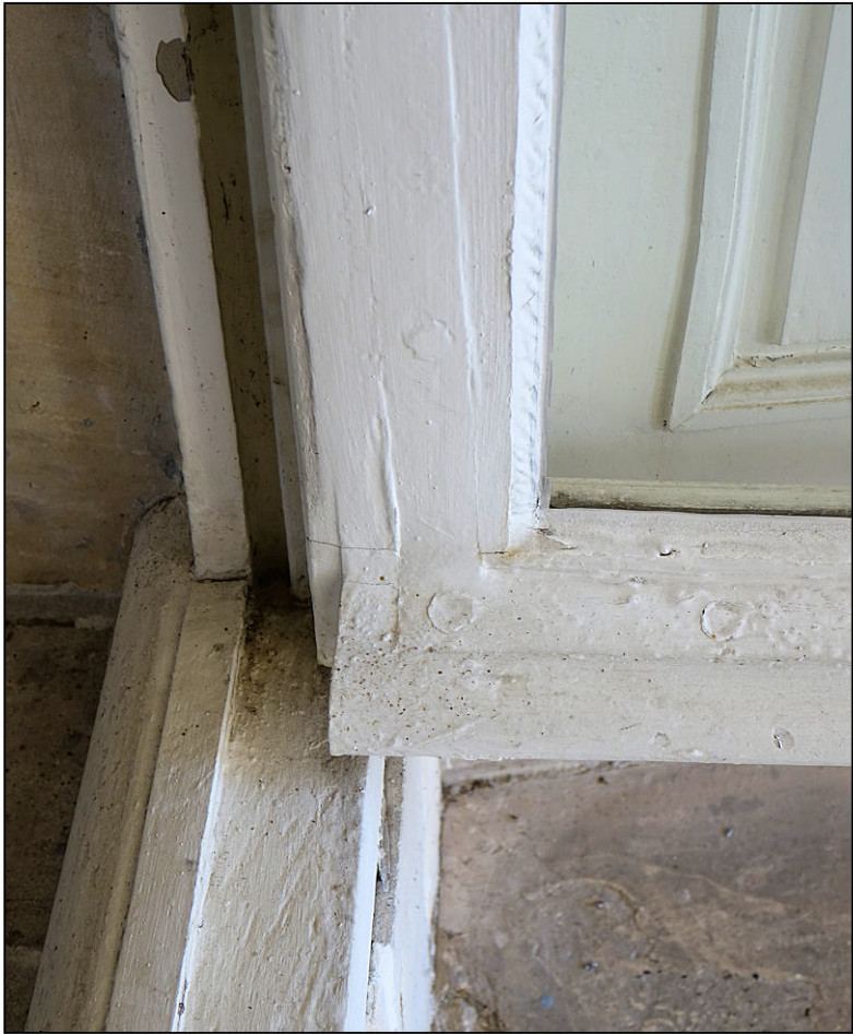
Fig. 5.4. pièce d'appui et jet d'eau
