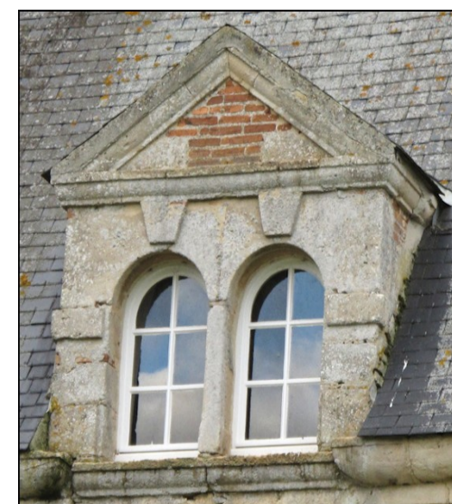
Fig. E.1. Lucarne qui accueillait le châssis au XVII e siècle.
