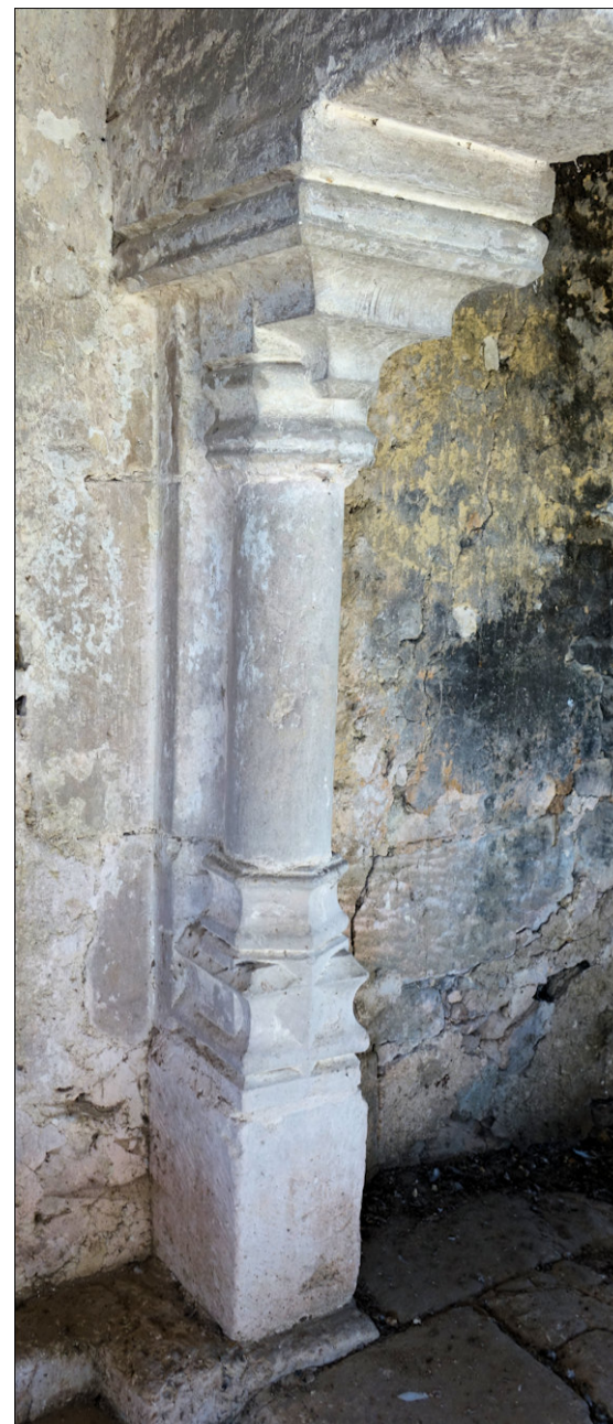
Fig. E.2. Détail d'un jambage de la cheminée du 1 er étage (fig. 1.4), comparable aux bases de la croisée
