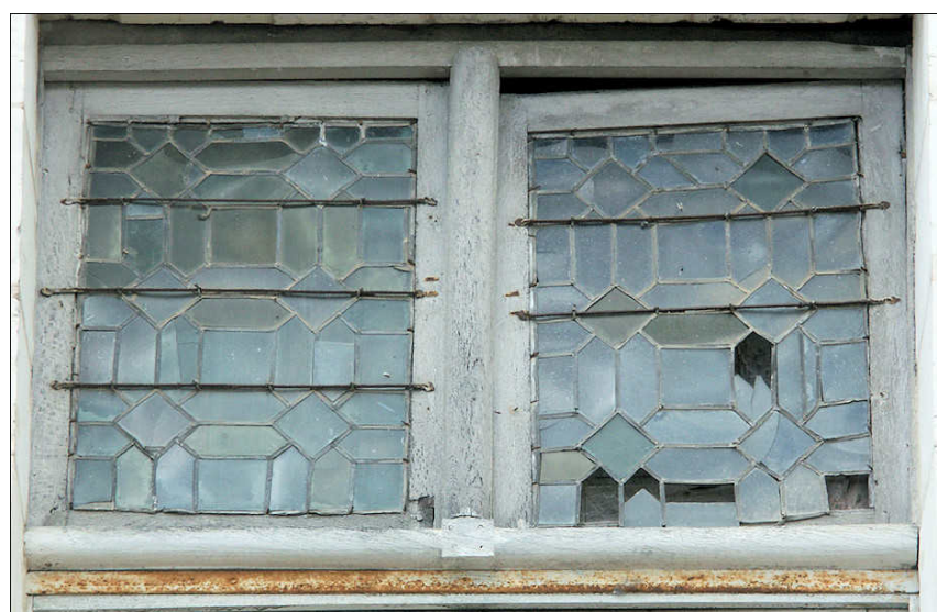
Fig. E.6. Vitrerie à « borne double et simple » selon Félibien.
