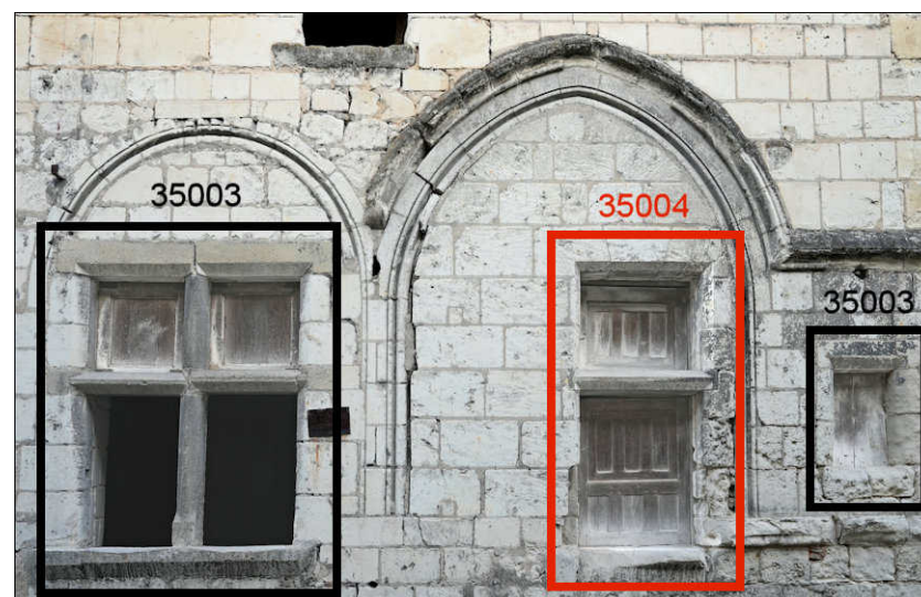
Fig. E.2. Les fenêtres de l'étage (les vestiges de la fin du X e siècle, en noir ; les vestiges de la fin du XVI e siècle, en rouge).
