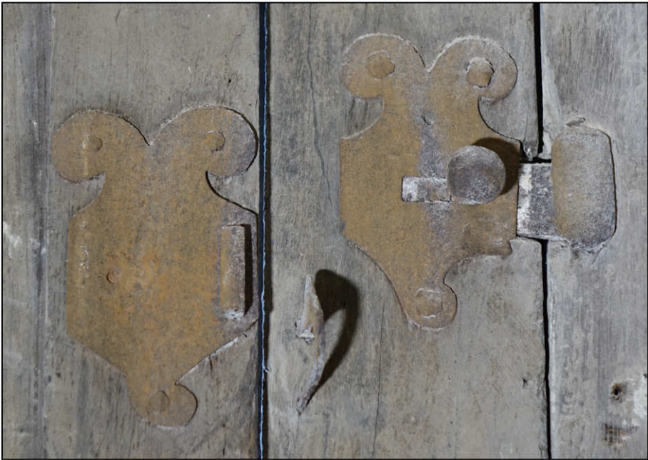
Fig. 2.2. Loquet et targette encloisonnée
