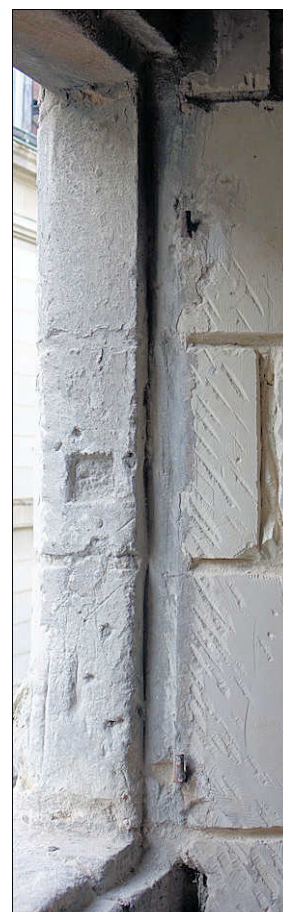
Fig. E.8. Ebrasement droit de la croisée au niveau du vantail inférieur
