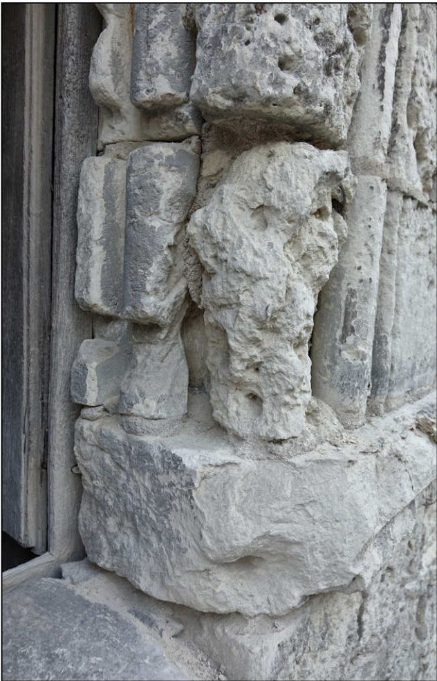
Fig. 1.3. Piédroit de l'ancienne fenêtre géminée
