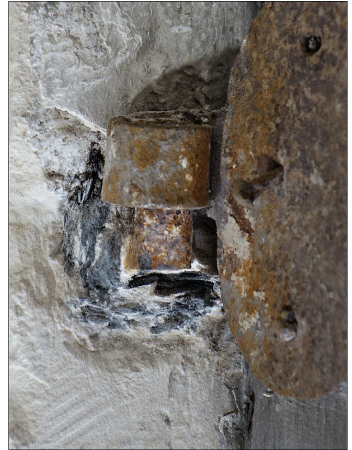
Fig. E.7. Penture à charnière et gond.
