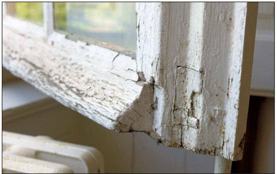
Fig. 2.3. Battant du milieu et jet d'eau (A.2.6)
