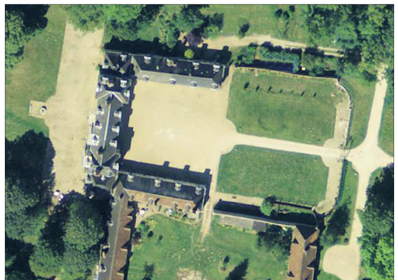
Fig. E.1. Vue aérienne du château Source geoportail.gouv.fr
