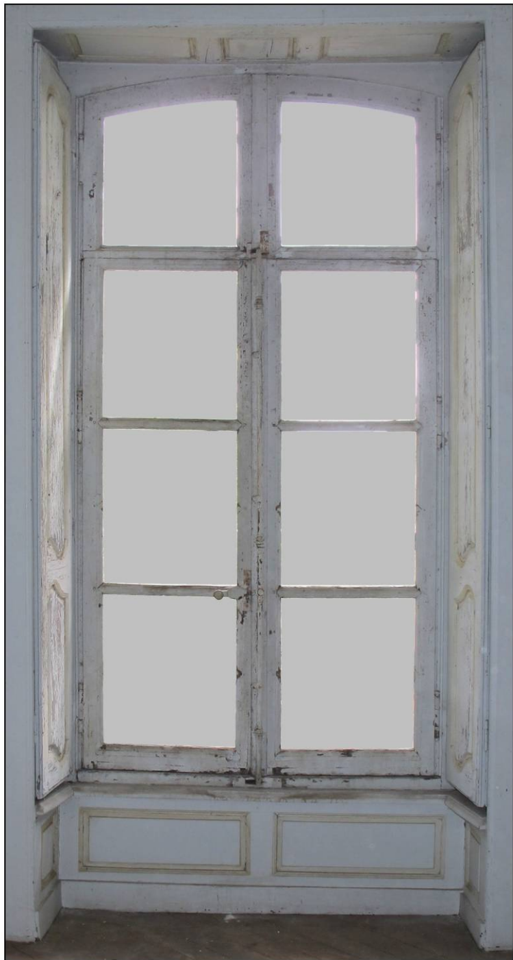
Fig. 2.1. Croisée (élévation intérieure)
