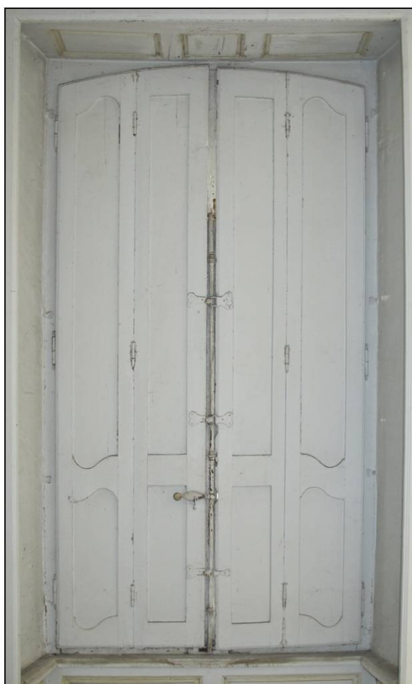
Fig. 2.4. Croisée (élévation intérieure)
