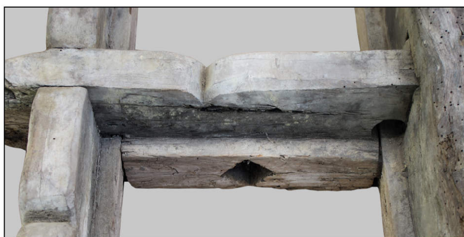
Fig. 3.6. Sous-face du croisillon
