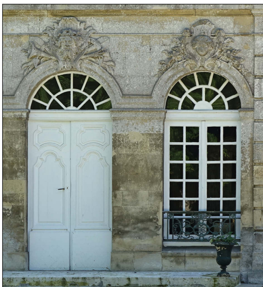
Fig. 1.3. Porte et croisée en plein-cintre (façade nord-est)
