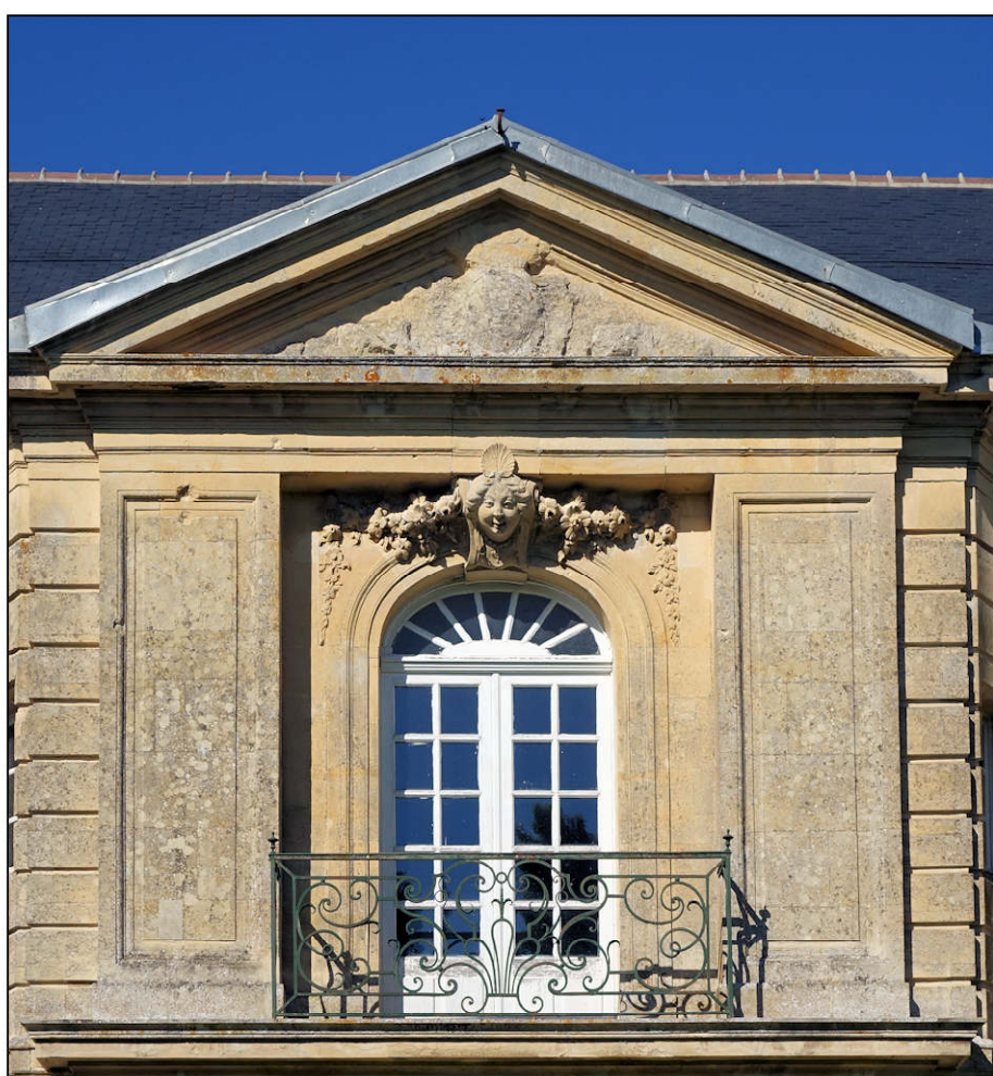
Fig. 1.2. Etage de l'avant-corps (façade sud-ouest)
