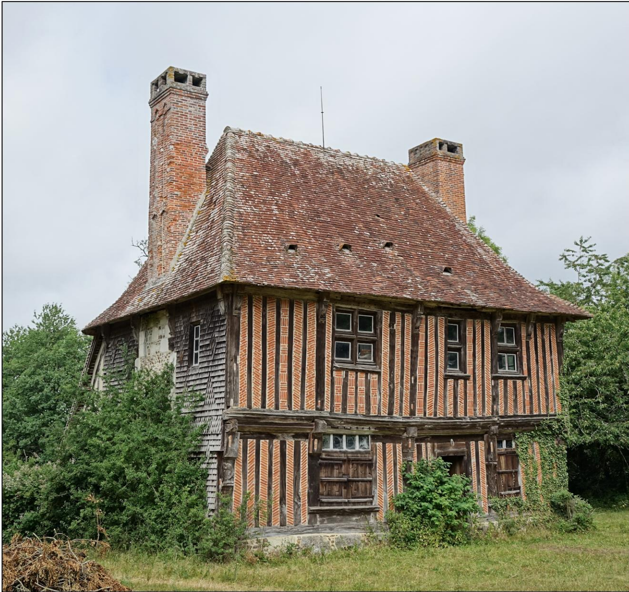
Fig. 1.1. Manoir (angle sud-est)
