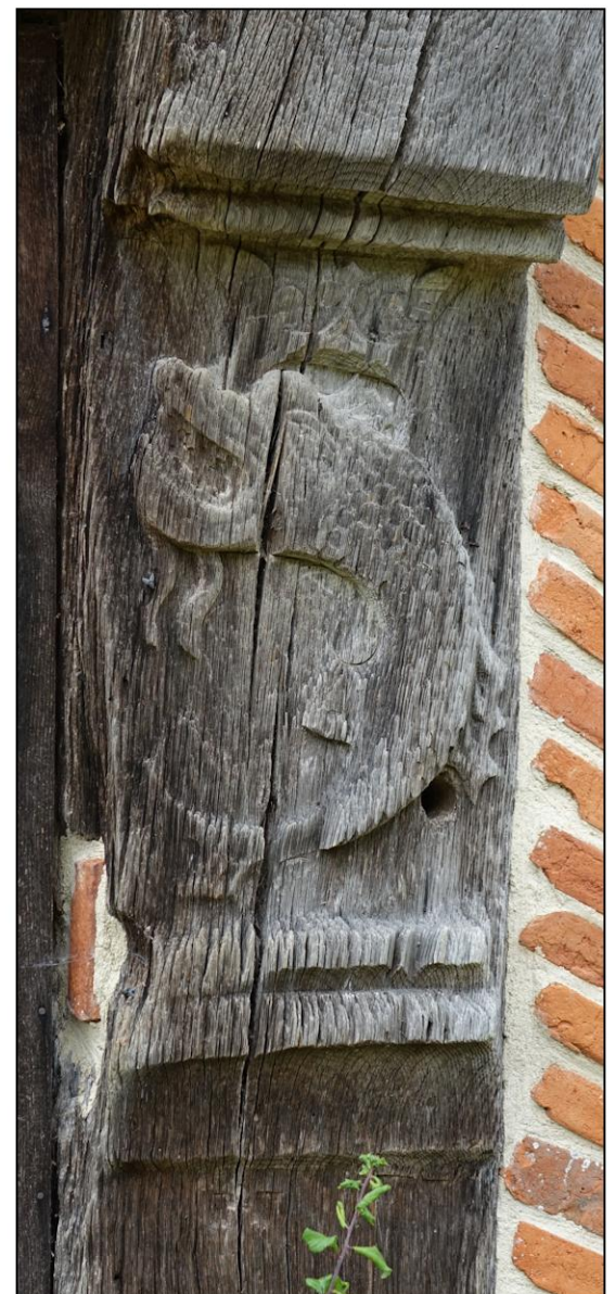
Fig. 1.4. Poteau d'angle sud-est
