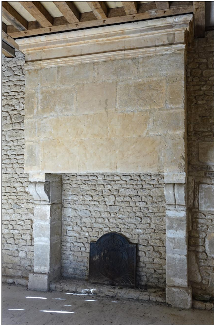
Fig. E.3 Cheminée de la pièce éclairée par la croisée A. A noter qu'elle a été remontée ainsi que le mur qui la soutient lors d'une récente restauration.
