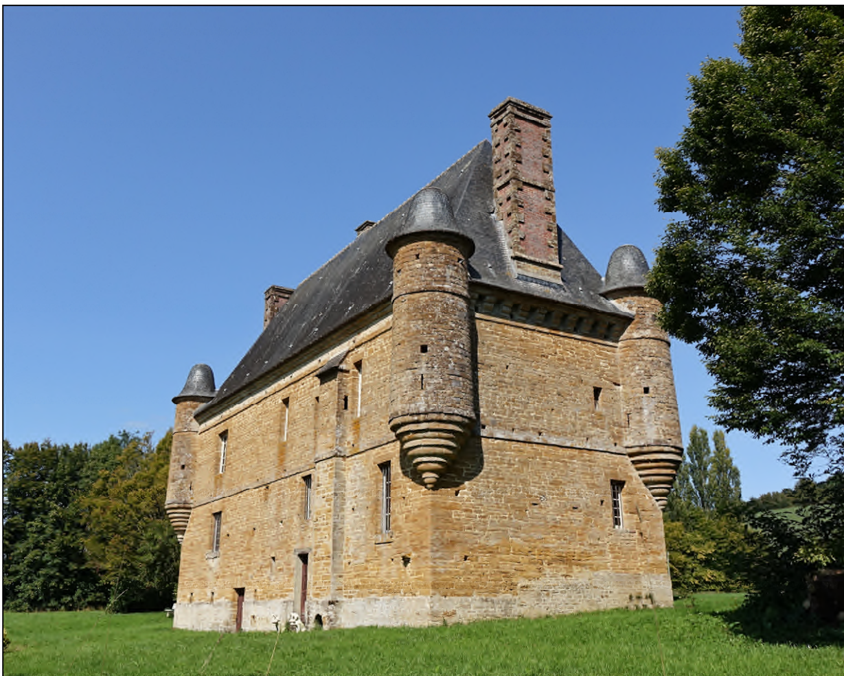
Fig. 1.2. Façades ouest et sud
