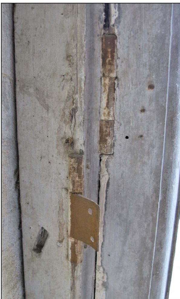
Fig. 10.3. Fiches (voilet et vantail vitré)
