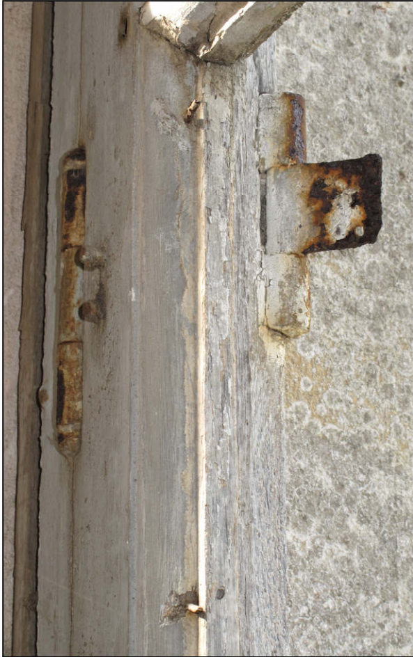
Fig. 5.1. Fiches (vantail gauche et contrevent)
