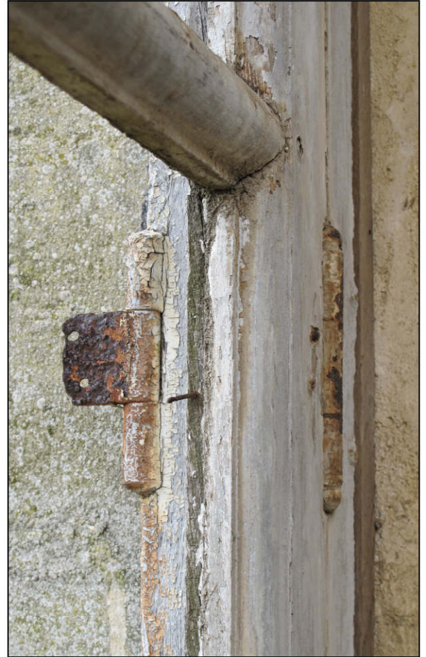
Fig. 5.3. Fiches (vantail droit et contrevent)
