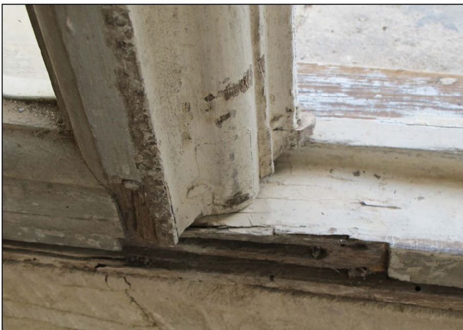
Fig. 3.6. Pièce d'appui et vantail gauche
