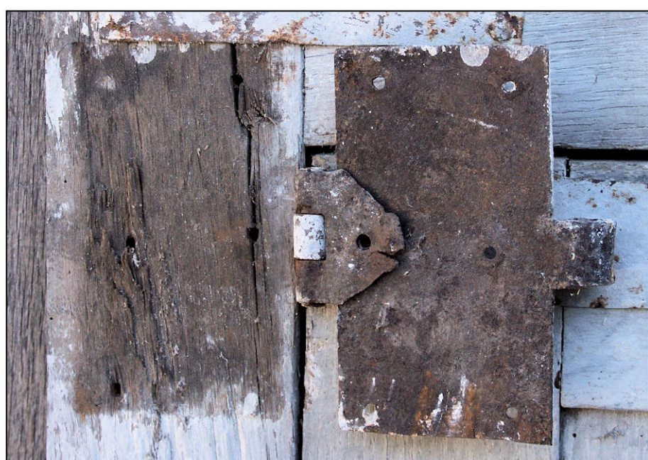
Fig. 2.3. Penture à charnière (platine retournée)
