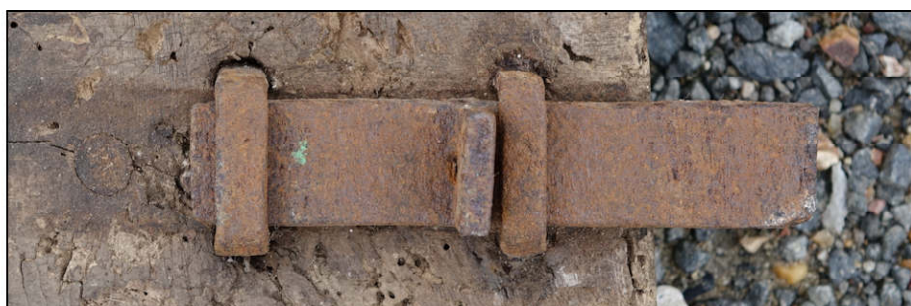
Fig. 1.3. Targette (vantaill inférieur)
