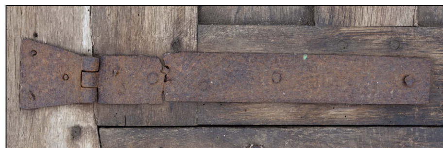
Fig. 1.4. Penture à charnière (vantaill inférieur)
