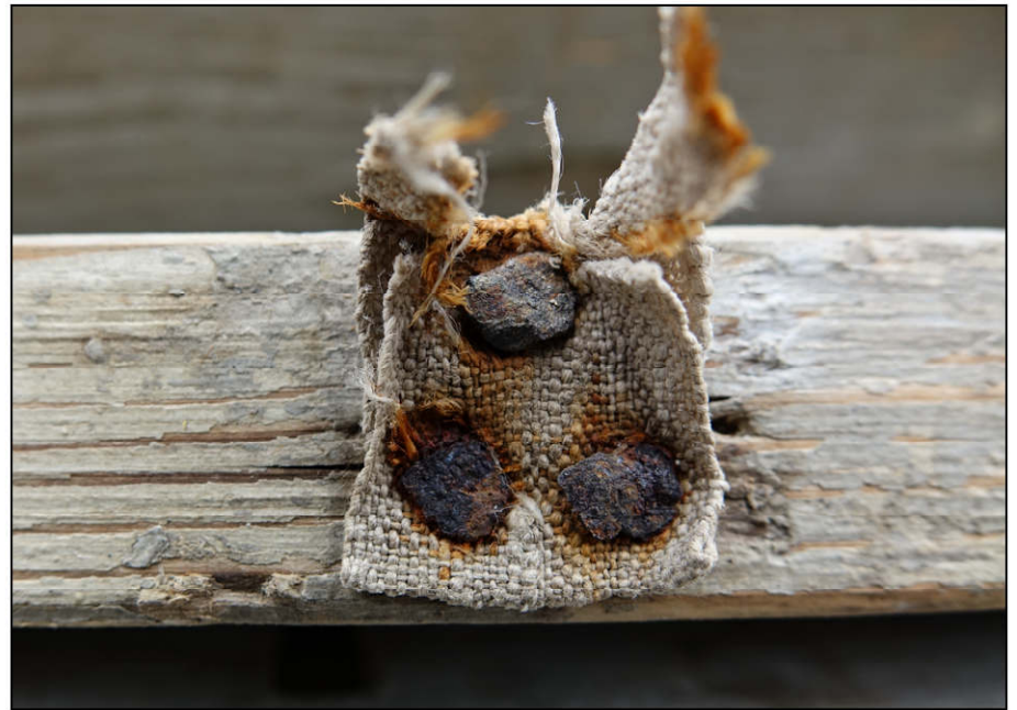
Fig. 7.4. Fixation d'un cordon sur la lame mouvante
