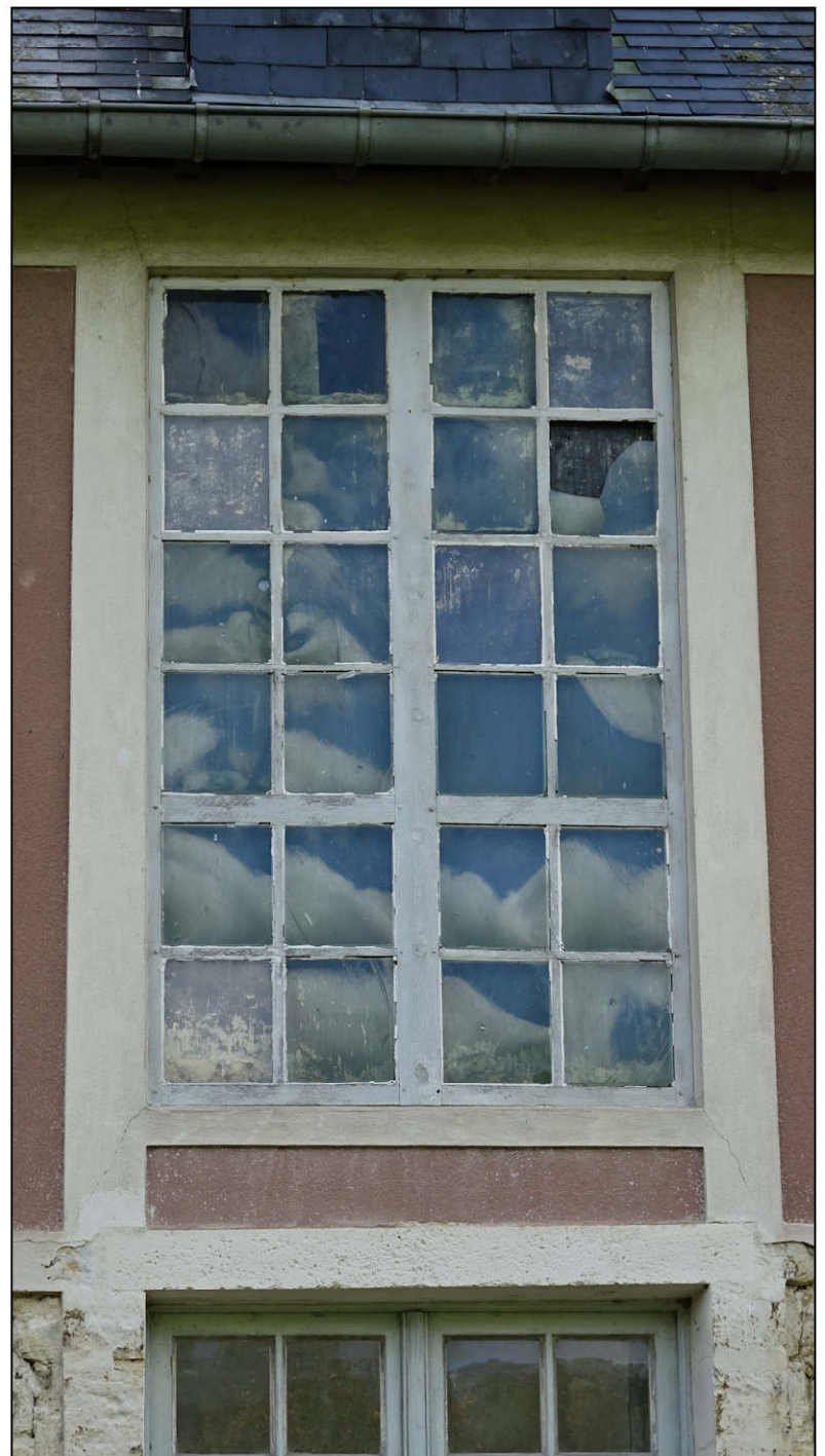
Fig. 1.4. Fenêtre de la cinquième travée de l'étage (nord-est)
