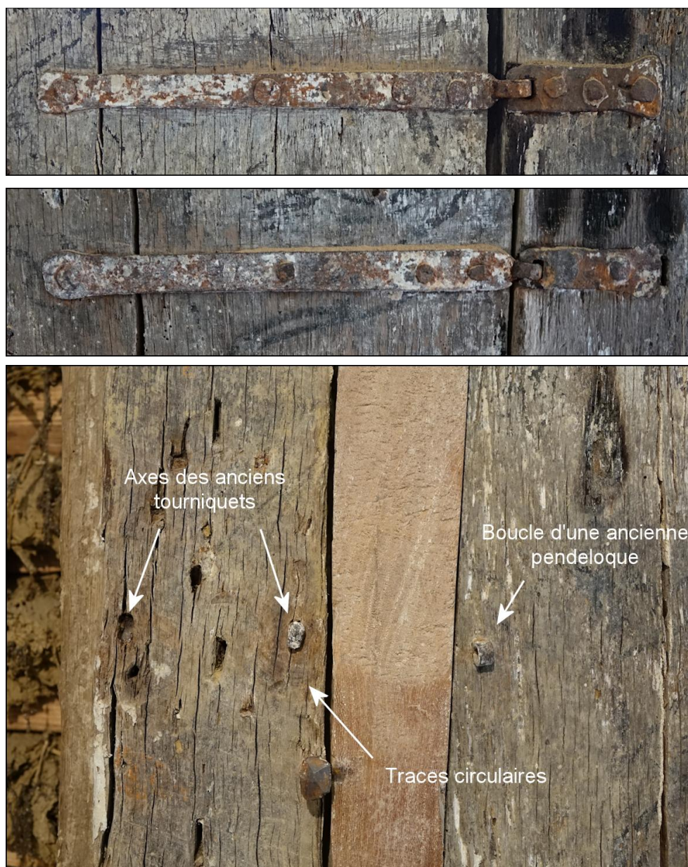
Fig. E.2. et E.3. Les deux pentures du volet droit.
