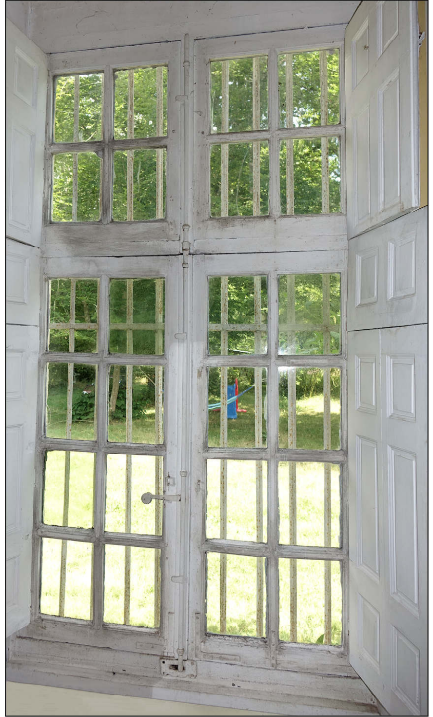
Fig. 7.2. Pavillon nord / chapelle (façade nord)
