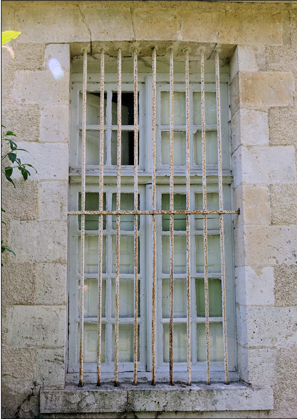
Fig. 7.1. Pavillon nord / Chapelle (façade nord)
