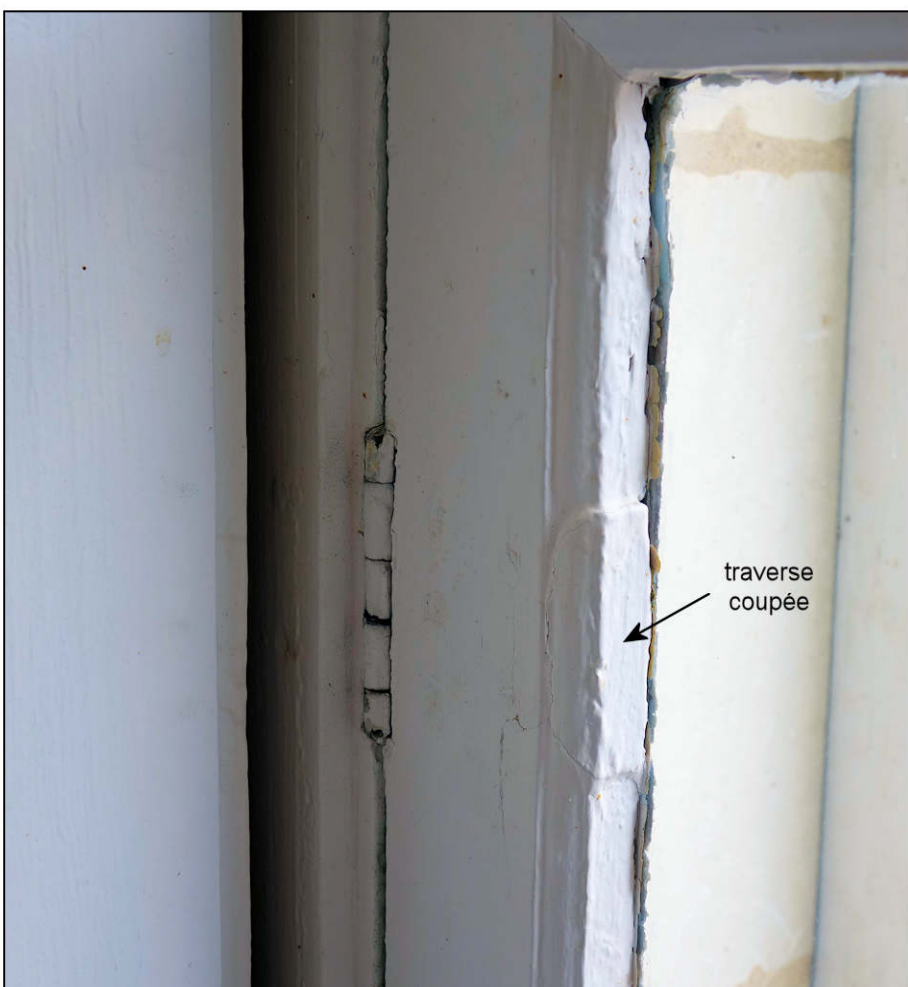
Fig. 6.5. Traverse coupée du vantail vitré traverse coupée
