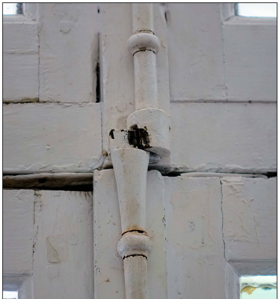
Fig. 6.4. Espagnolette (liaison de tringle à moufle)
