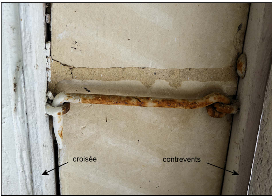
Fig. 6.3. Crochet de contrevents croisée contrevents
